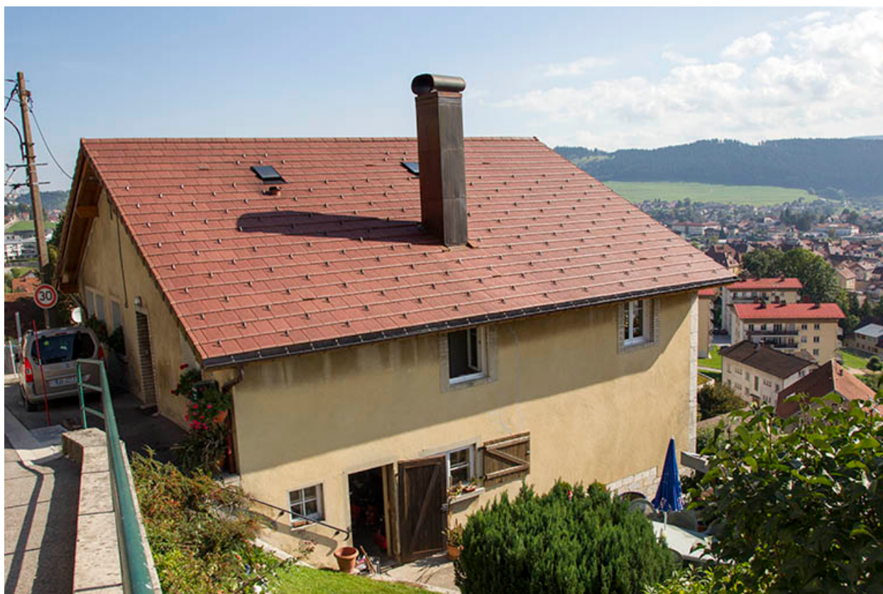
Façades latérale droite et antérieure.
