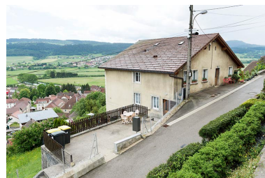
Façades latérale gauche et antérieure. Phot. Sonia Dourlot IVR43_20182500698NUC4A
