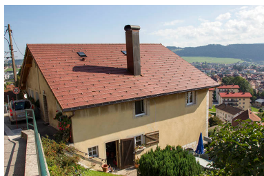
Façades latérale droite et antérieure. Phot. Yves Sancey IVR43_20132502397NUC2A
