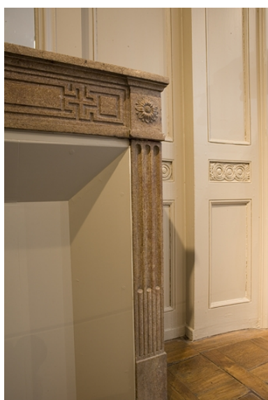
Détail de la partie droite de la cheminée située au premier étage. Phot. Yves Sancey IVR43_20082500600NUC2A
