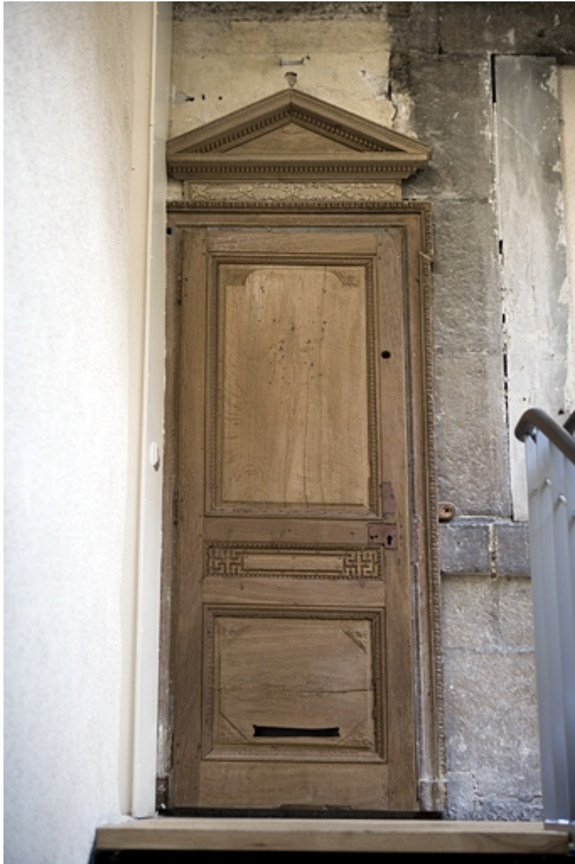
Détail de la porte d'entrée du logis secondaire.
