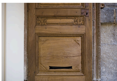
Détail des grecques ornant la porte d'entrée du logis secondaire. Phot. Yves Sancey IVR43_20082500592NUC2A
