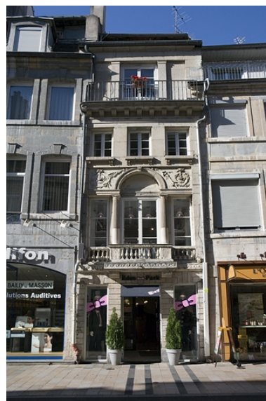
Vue d'ensemble de la façade sur rue, de face. Phot. Yves Sancey IVR43_20082500589NUC2A
