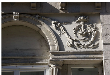
Détail d'un rinceau de feuillage encadrant l'arc de la serlienne. Phot. Yves Sancey IVR43_20082500594NUC2A
