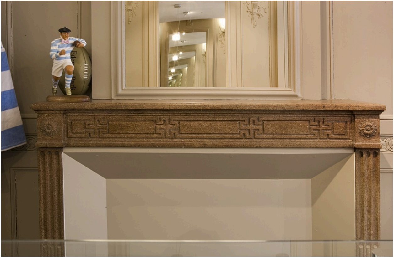
Détail de la tablette de la cheminée située au premier étage.
