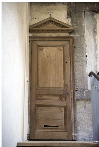
Détail de la porte d'entrée du logis secondaire. Phot. Yves Sancey IVR43_20082500591NUC2A
