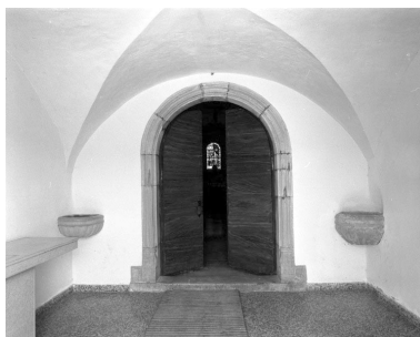
Le vestibule sous la tour-clocher. Phot. Yves Sancey IVR43_19943900644X
