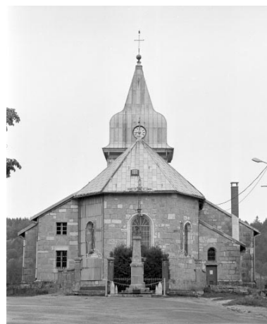
Extérieur : l'abside, vue de face. Phot. Yves Sancey IVR43_19943901017X
