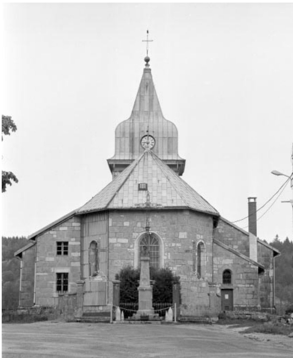
Extérieur : l'abside, vue de face.
