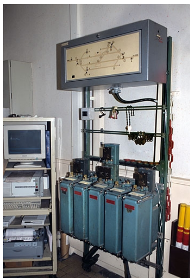
Vue d'ensemble, de trois quarts droite. Le tableau de contrôle optique surmonte les commutateurs. A gauche, ordinateur
