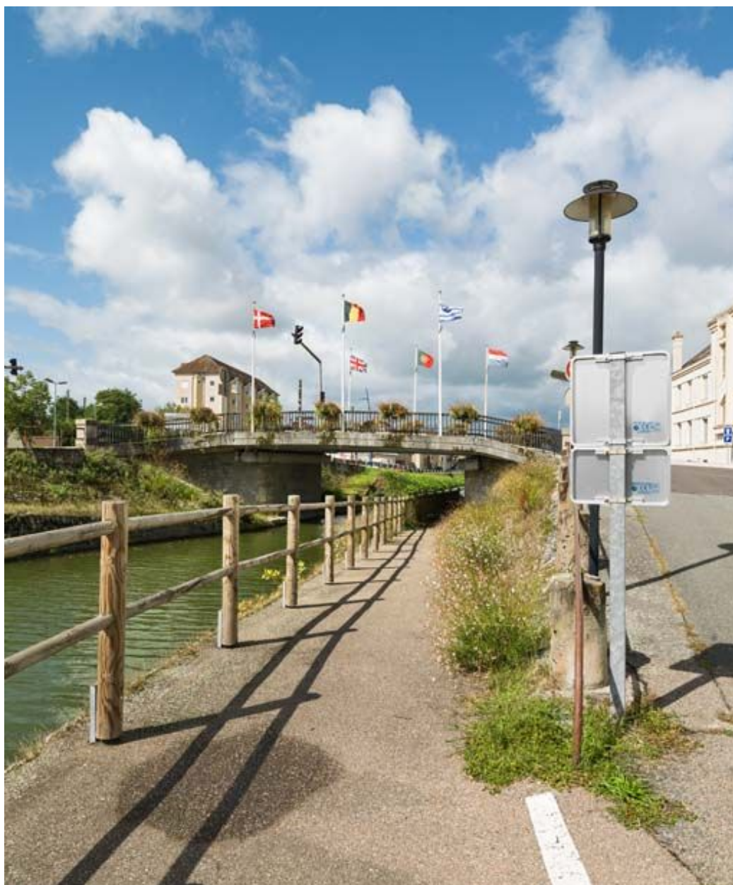
Vue d'ensemble du pont.
