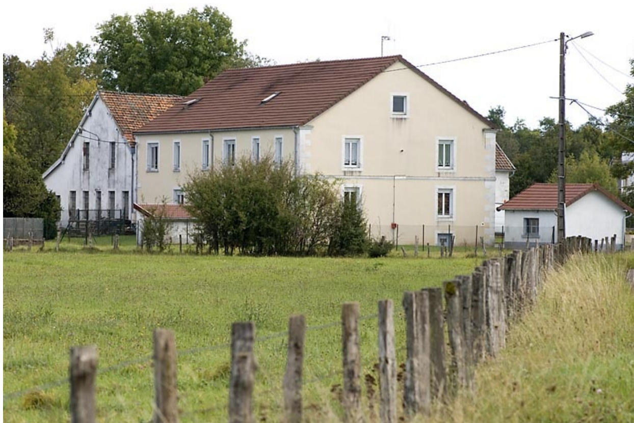
Vue rapprochée depuis le nord-ouest.
