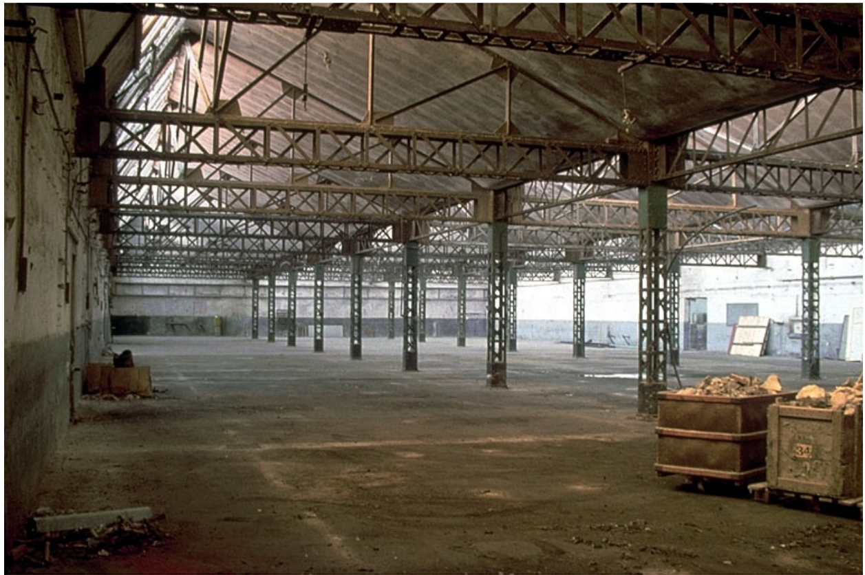
Atelier de fabrication (1), vu depuis l'angle nord-ouest.
