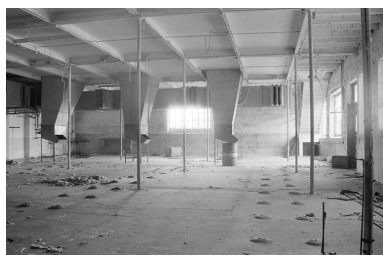
Atelier de bobinage (7). L'alimentation des bobinoirs en cannettes de filature s'effectuait depuis l'étage de comble par les trois conduits. Phot. Laurent Poupard IVR43_19883900157Z
