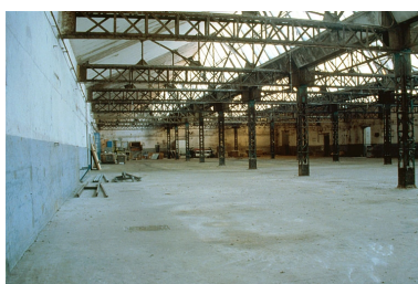
Atelier de fabrication (1), depuis l'angle sud-est. La première porte à droite est l'ancienne entrée principale de l'usine. Phot. Laurent Poupard IVR43_19883900163ZA
