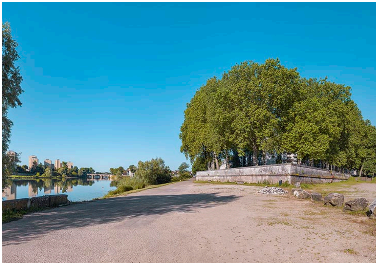
Le bastion, vue depuis l'amont.
