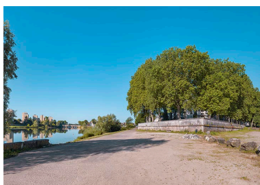
Le bastion, vue depuis l'amont. Phot. Thierry Kuntz IVR26_20247100051NUC4A
