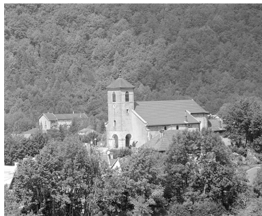
Vue de situation depuis le sud-ouest.
