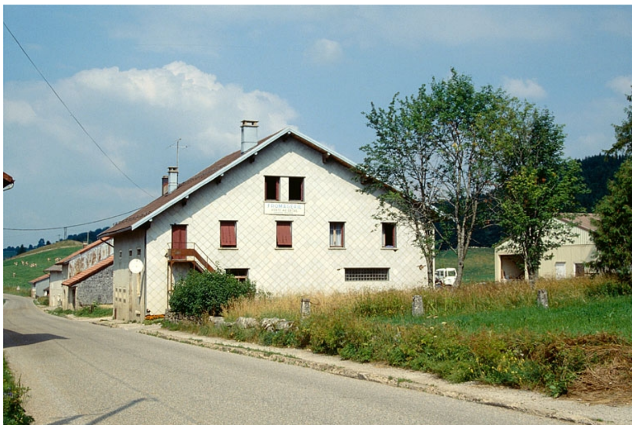
Façade latérale droite.
