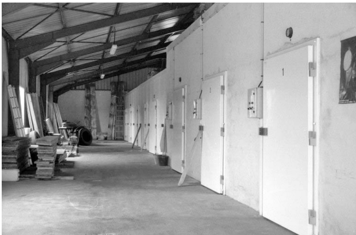
Couloir desservant les pièces d'affinage.
