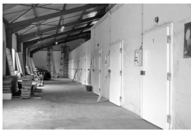
Couloir desservant les pièces d'affinage. Phot. Laurent Poupard IVR43_19913901207Z
