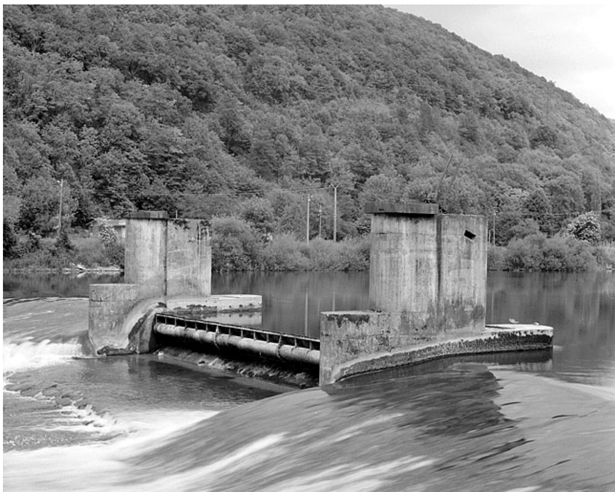
La vanne clapet.
