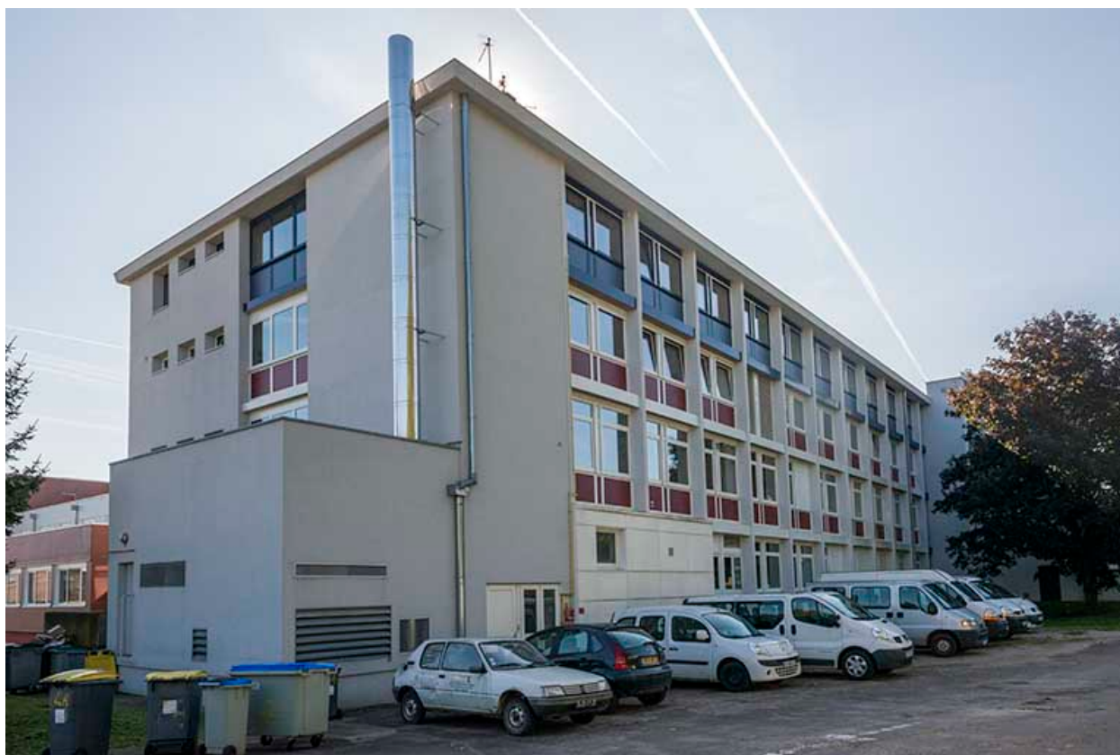
Chaufferie à l'angle nord-ouest de l'externat.
