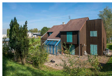
Façade postérieure sud- ouest du pavillon du directeur.
