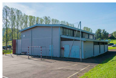
Angle nord et pignon nord-est du gymnase Phot. Mary Ruffinoni IVR43_20137000736NUC4A
