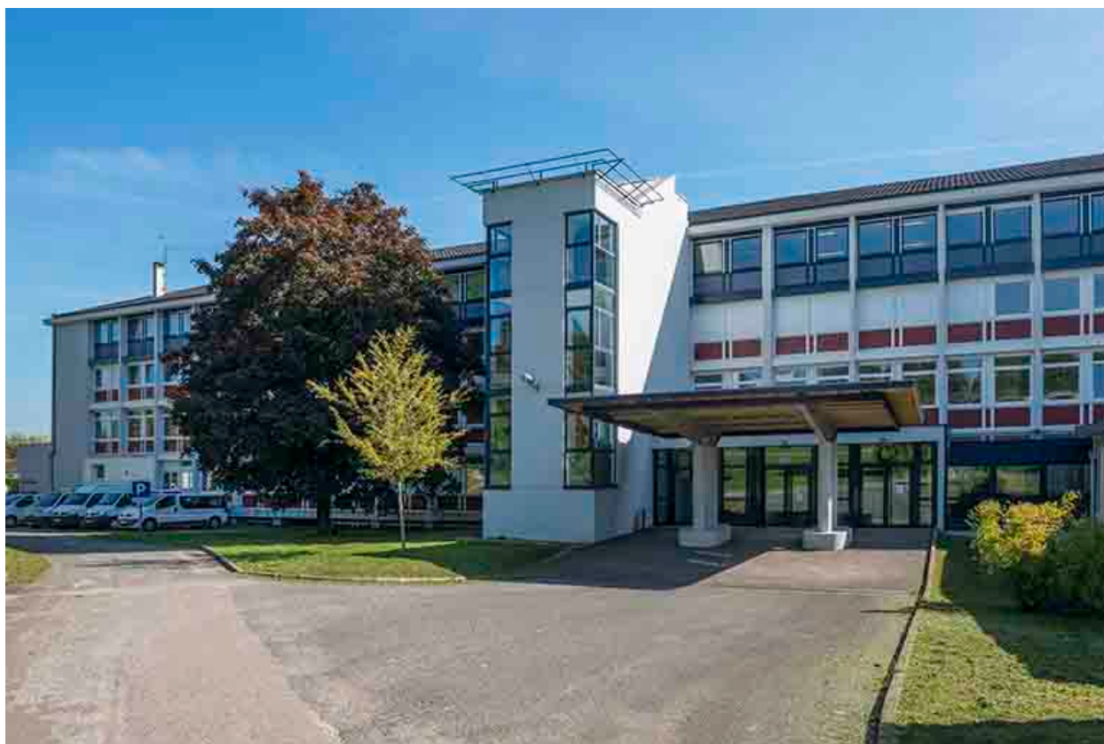
Façade ouest de l'externat.
