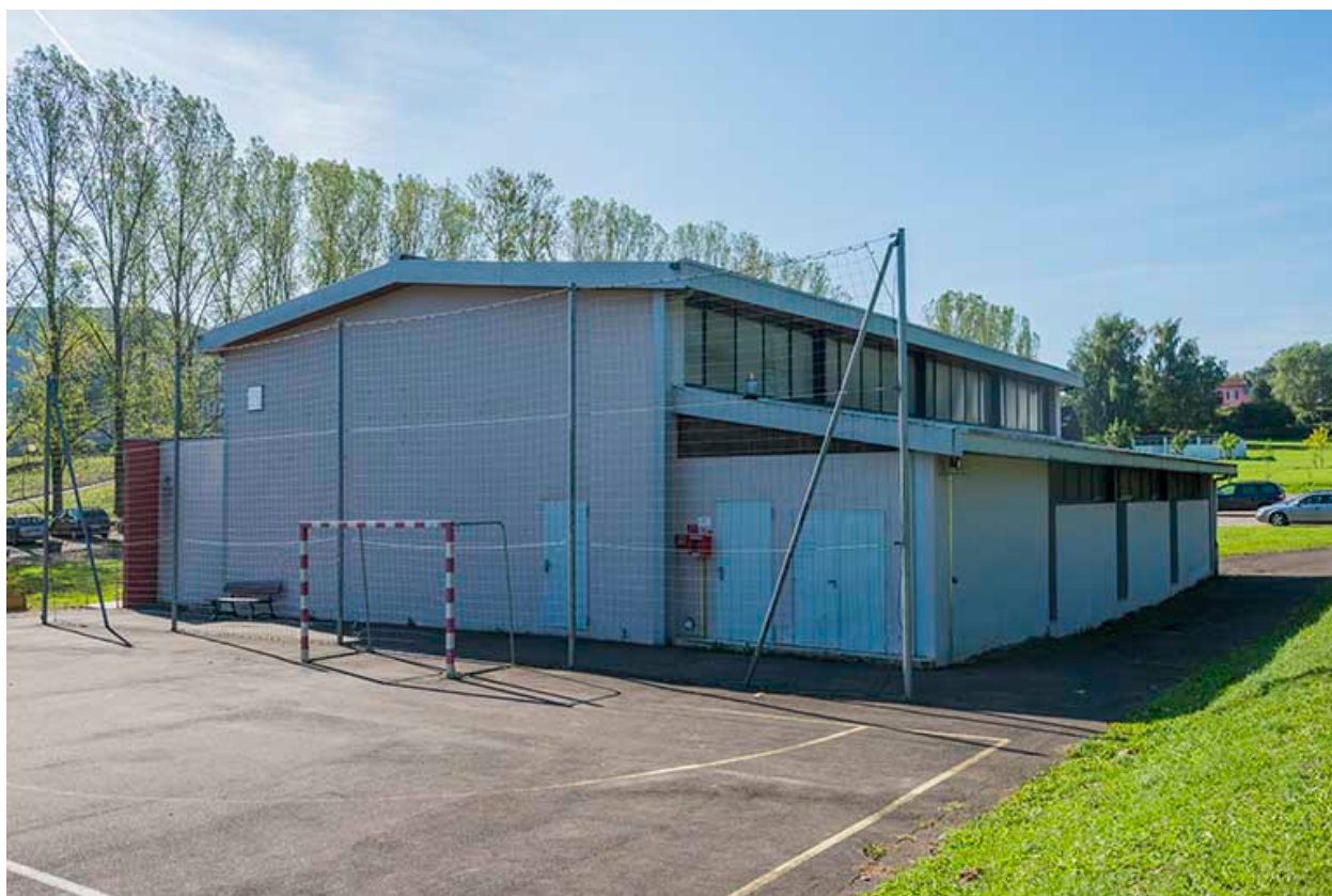
Angle nord et pignon nord-est du gymnase
