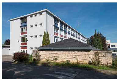
Façade sud de l'administration. Phot. Mary Ruffinoni IVR43_20137000744NUC4A
