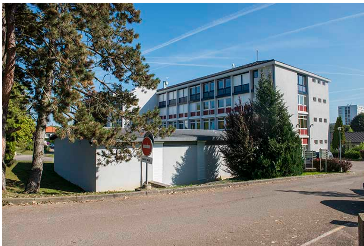
Façade sud de l'amphithéâtre.
