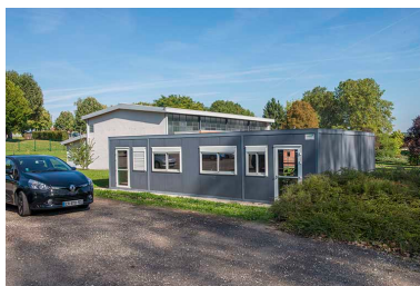
Angle sud du préfabriqué ouest. Phot. Mary Ruffinoni
