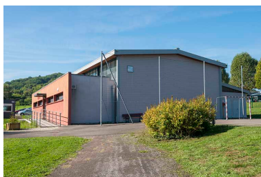
Angle est et pignon nord-est du gymnase. Phot. Mary Ruffinoni IVR43_20137000735NUC4A
