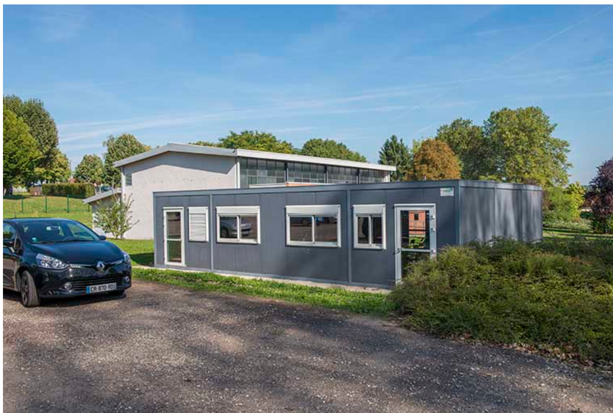
Angle sud du préabriqu  west.
