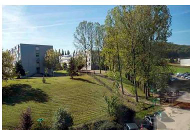
Au second plan, angle nord- est de l'internat du lycée Belin affecté au lycée Munier.
