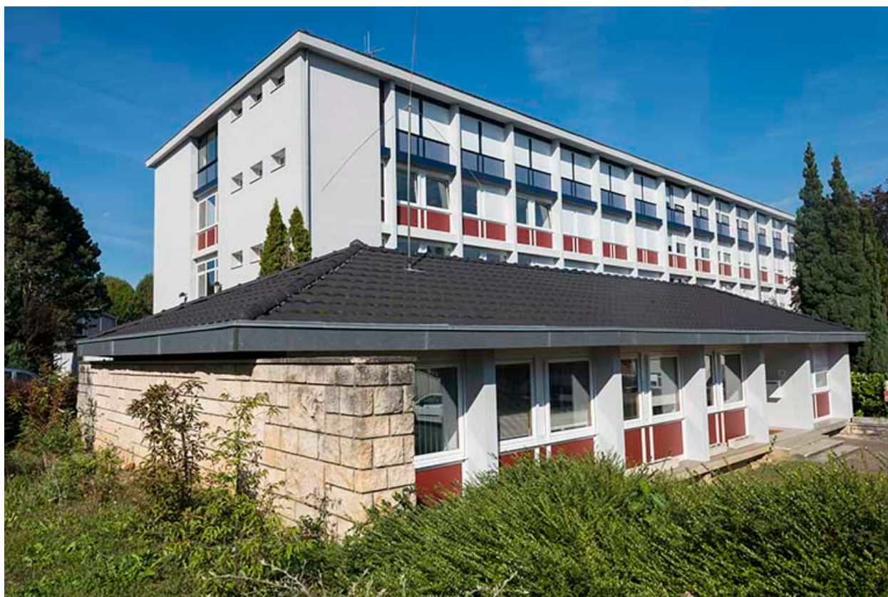
Angle sud-est et façade est de l'administration.
