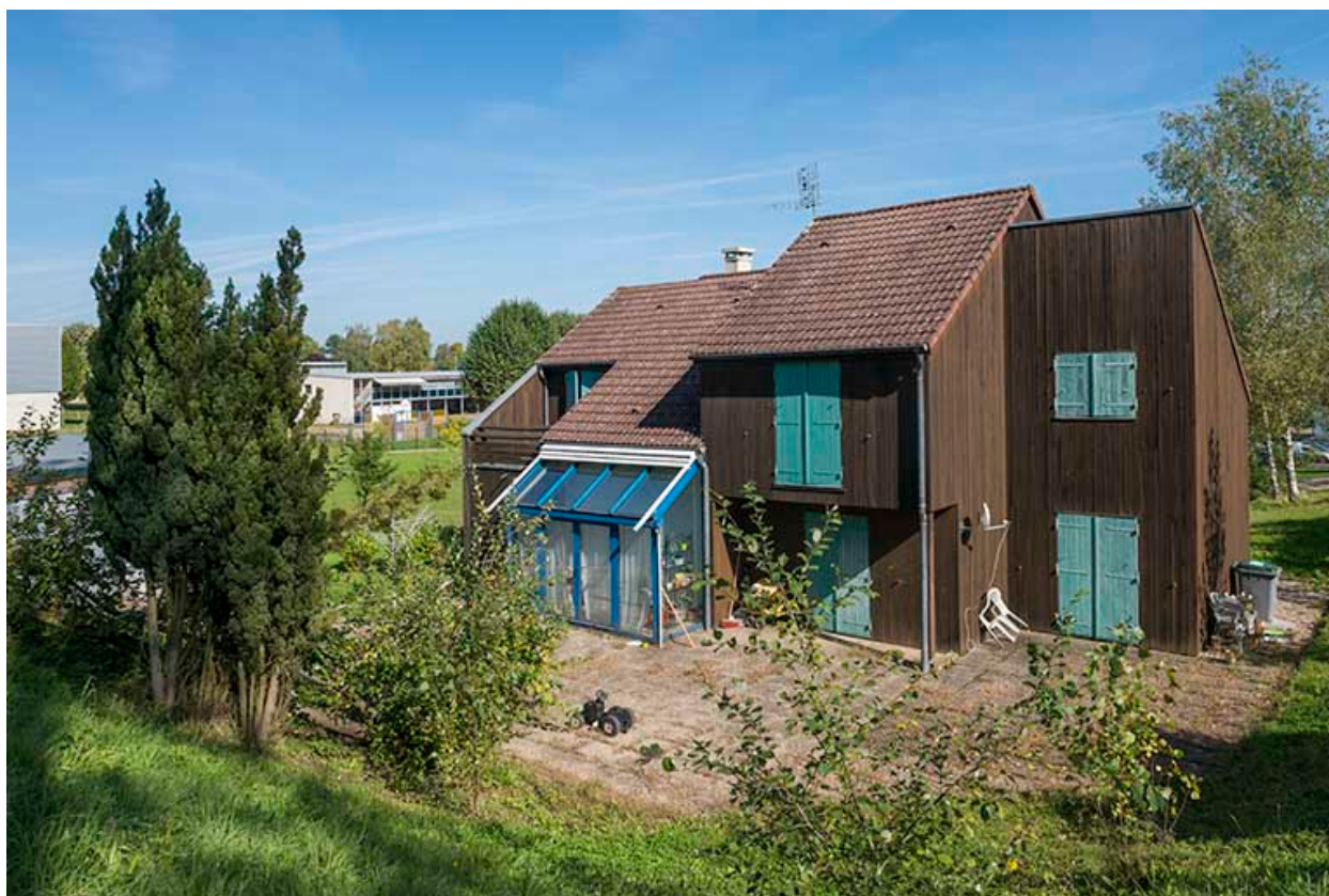
Façade postérieure sud-ouest du pavillon du directeur.
