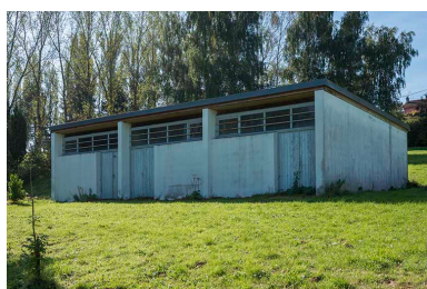
Angle nord-ouest et façade nord-est du dépôt.
