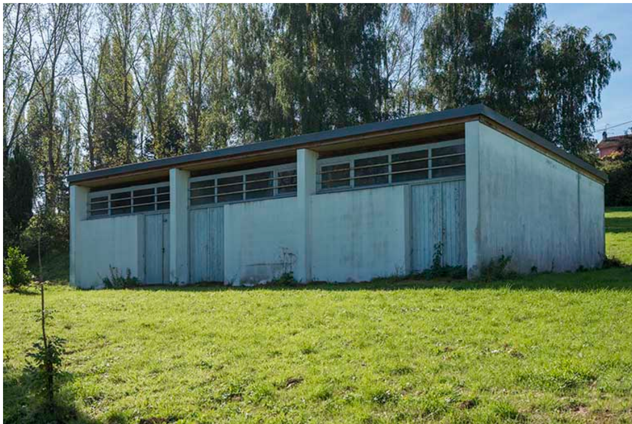
Angle nord-ouest et façade nord-est du dépôt.
