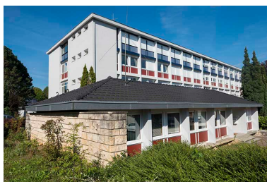
Angle sud-est et façade est de l'administration. Phot. Mary Ruffinoni IVR43_20137000733NUC4A
