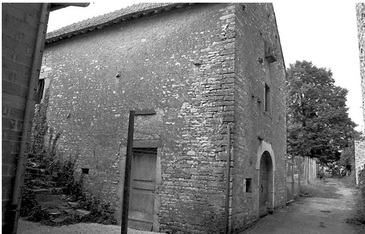
Façades antérieure et latérale droite.
