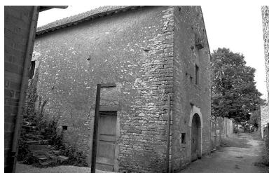
Façades antérieure et latérale droite.
