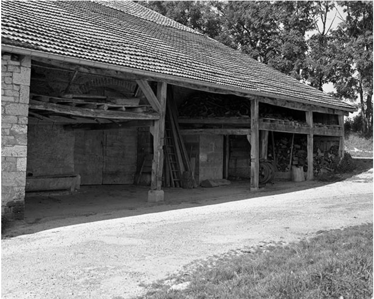
Façade latérale droite.
