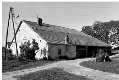
Vue de trois quarts droit. Phot. Bernard Lardière IVR43_19782500341X
