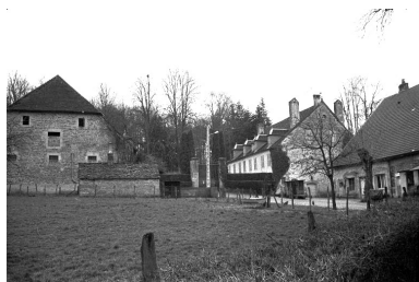
Vue générale. Phot. Guy Forestier IVR43_19743900415Z
