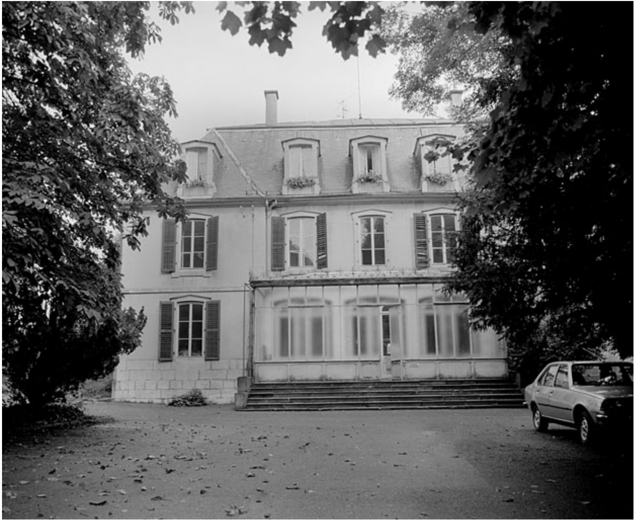
Façade sud en 1981.SRI. Enquête régionale sur les bâtiments industriels (1979-1981).
