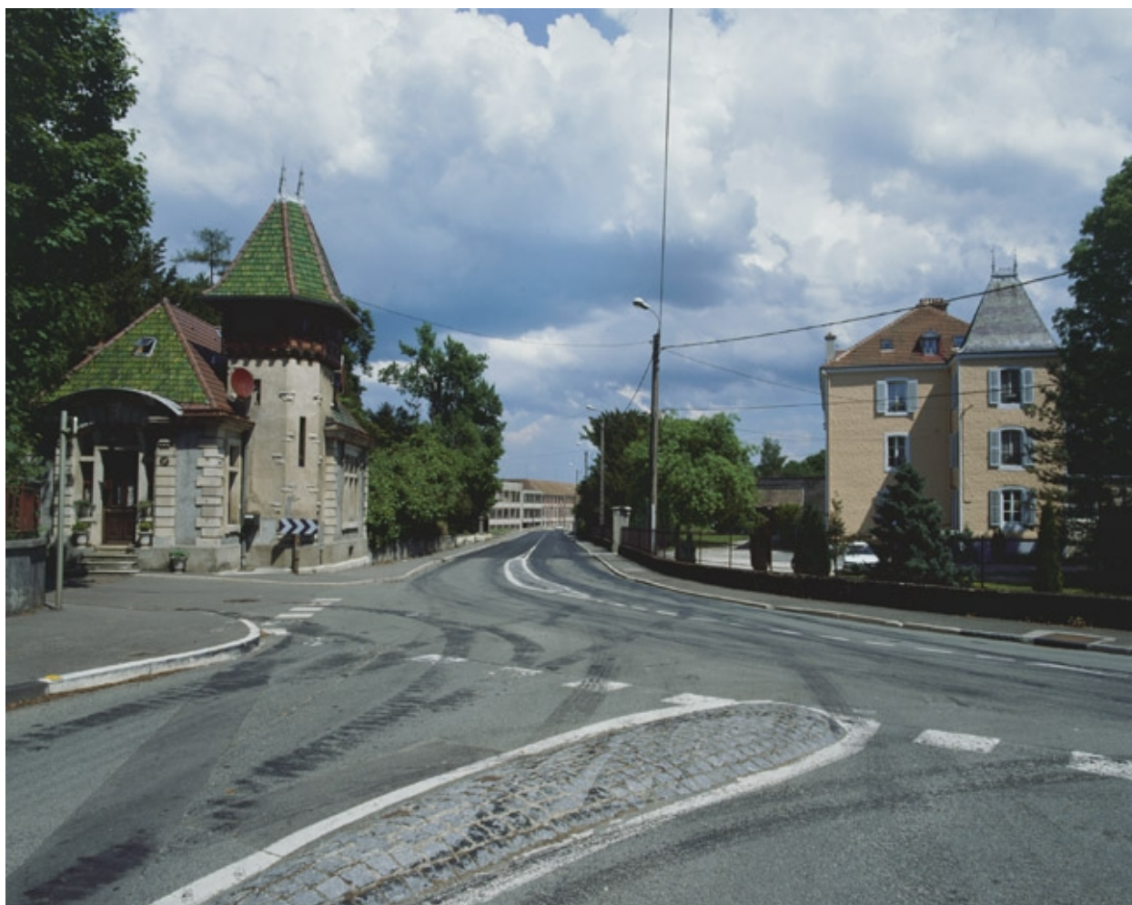
Vue d'ensemble de la conciergerie (à gauche).
