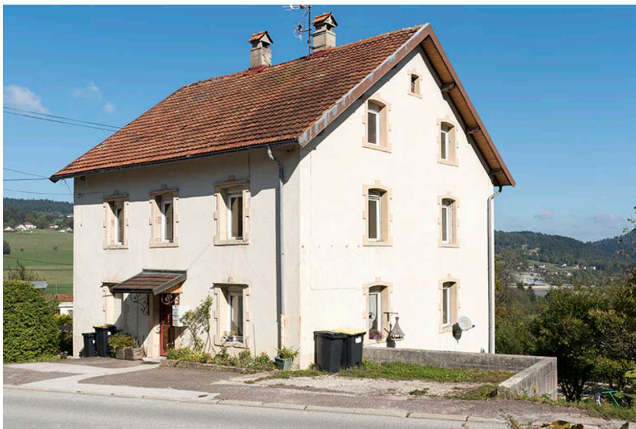
Façades antérieure et latérale droite.
