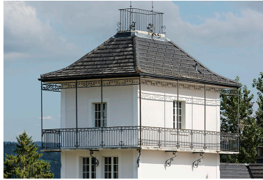
Tour : partie supérieure. Phot. Sonia Dourlot IVR43_20162501020NUC4A
