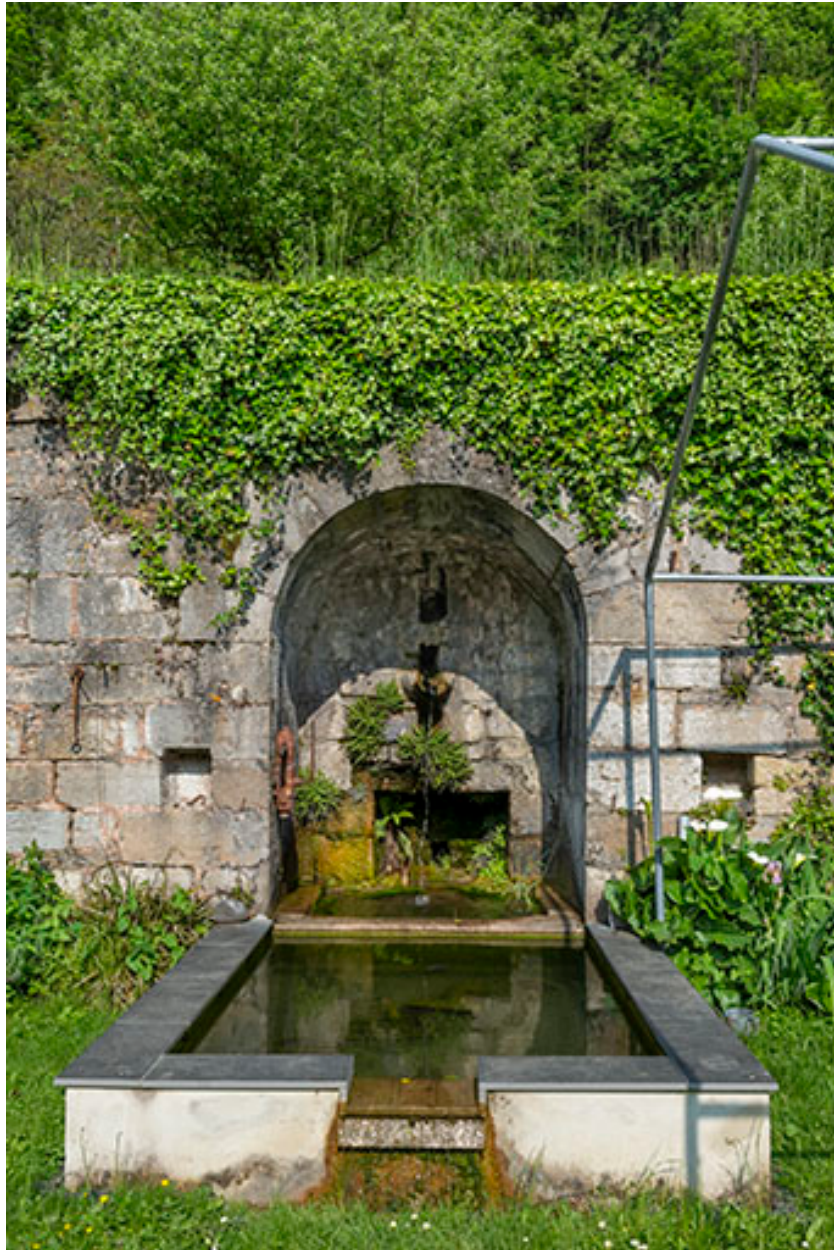
Fontaine dans la cours, au sud.
