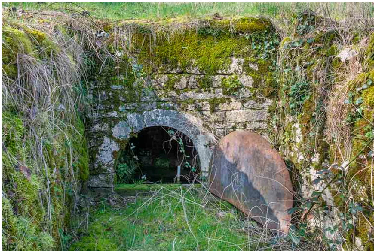
Captage de la source.
