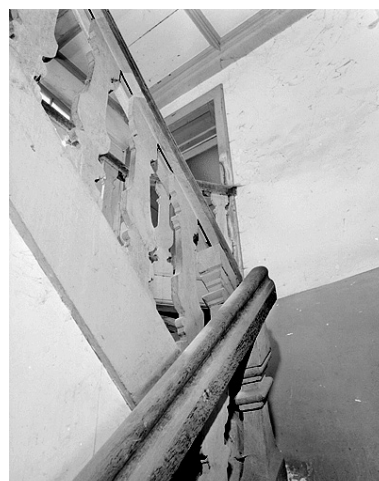
Escalier. Phot. Jérôme Mongreville IVR43_19872500474X
