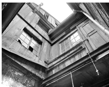
Cour. A gauche, cage d'escalier accolée au premier corps de bâtiment ; à droite, galerie de liaison. Phot. Jérôme Mongreville IVR43_19872500829X
