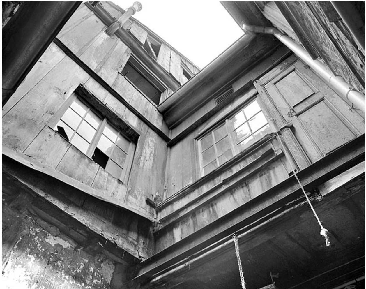
Cour. A gauche, cage d'escalier accolée au premier corps de bâtiment ; à droite, galerie de liaison.
