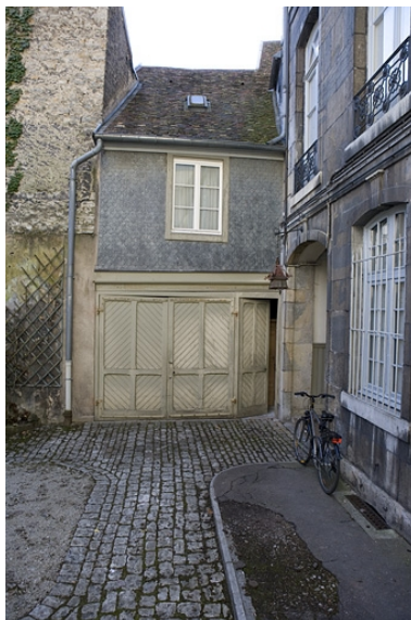
Détail d'une remise à droite de la cour. Phot. Yves Sancey IVR43_20092500251NUC2A
