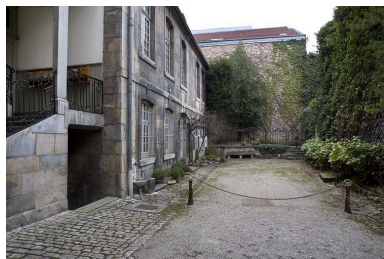
Vue d'ensemble rapprochée de l'aile gauche sur cour. Phot. Yves Sancey IVR43_20092500254NUC2A
