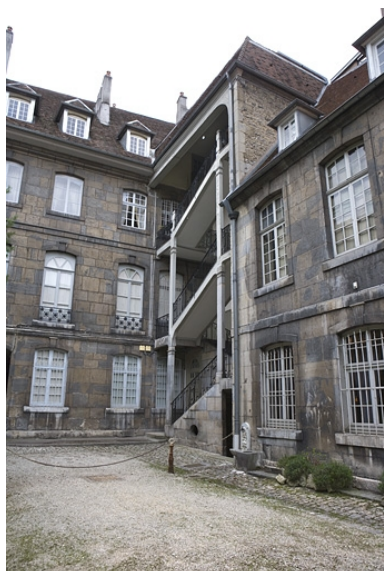
Vue d'ensemble de l'escalier à cage ouverte de trois quarts droit. Phot. Yves Sancey IVR43_20092500256NUC2A
