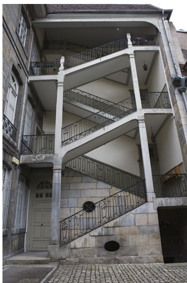
Vue d'ensemble de l'escalier à cage ouverte de face. Phot. Yves Sancey IVR43_20092500257NUC2A
