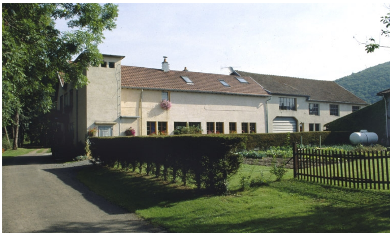
Atelier de fabrication nord depuis la rue.
