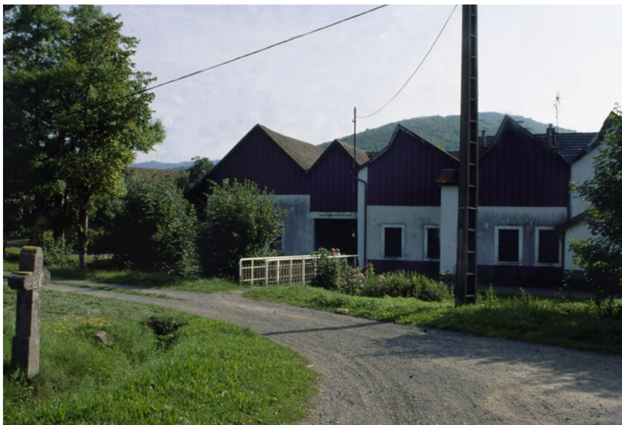
Vue d'ensemble depuis l'ouest.
