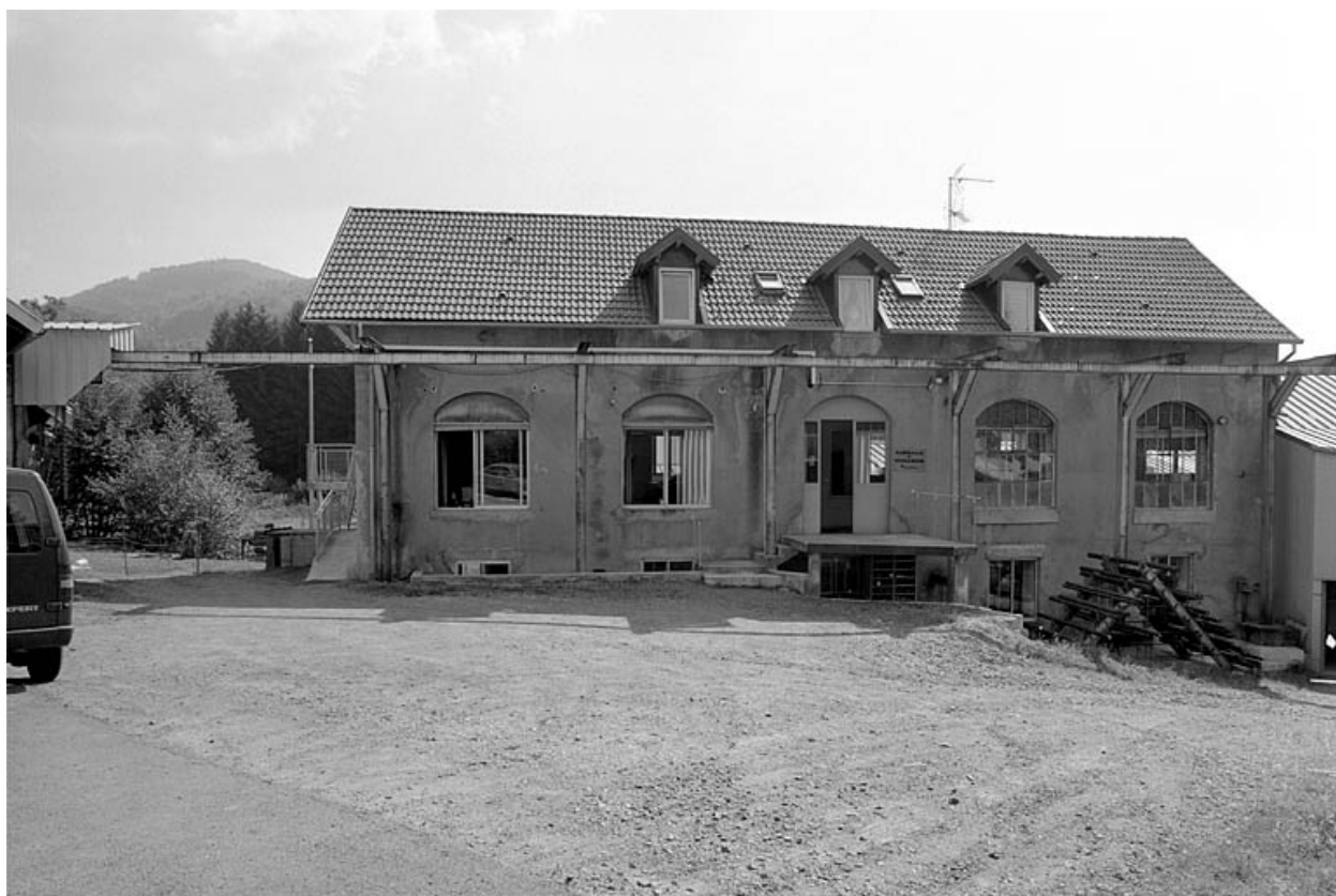
Façade ouest de l'atelier de fabrication primitif.
