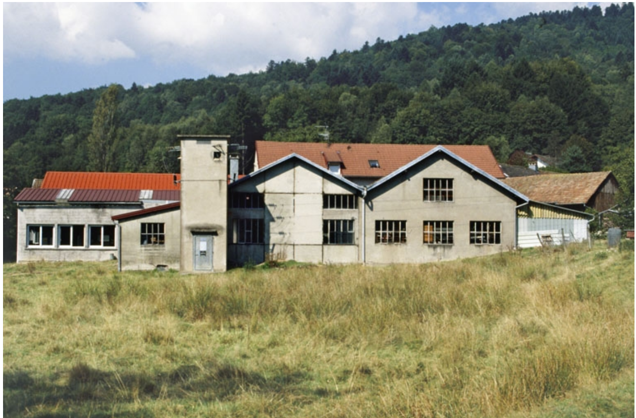
Ateliers de fabrication depuis l'est.
