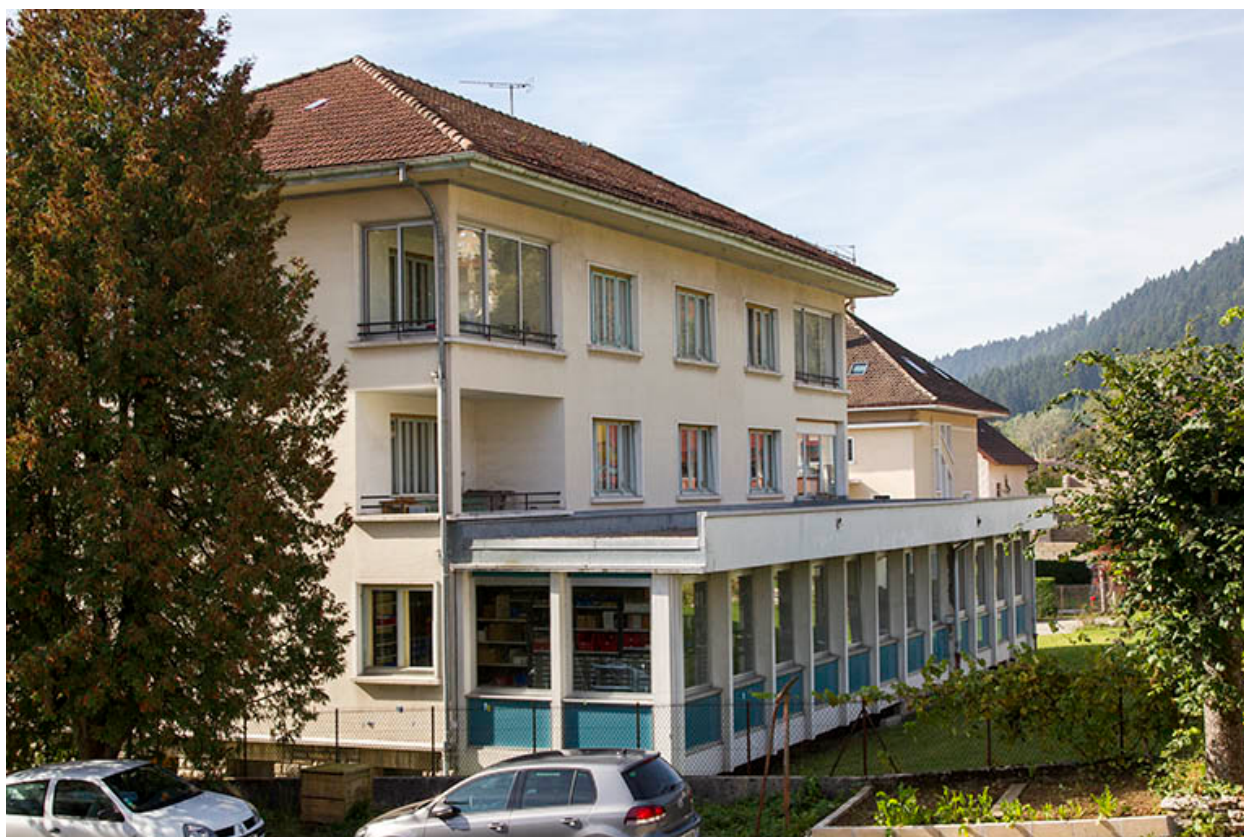
Façade postérieure, vue en enfilade.
