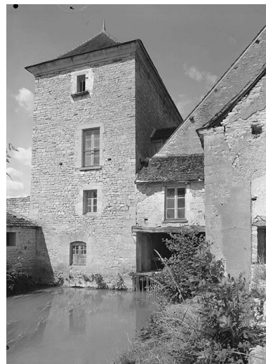
Vue sur la tour. Phot. Jean-Luc Duthu IVR26_19748901375V
