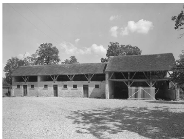
Vue sur les dépendances. Phot. Jean-Luc Duthu IVR26_19748901376V
