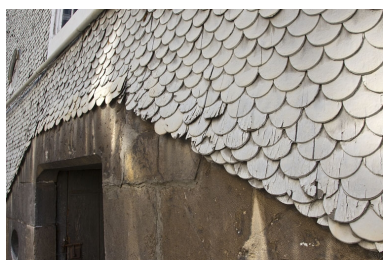
Détail des tavaillons recouvrant l'extérieur de la cage d'escalier. Phot. Yves Sancey IVR43_20112500876NUC2A
