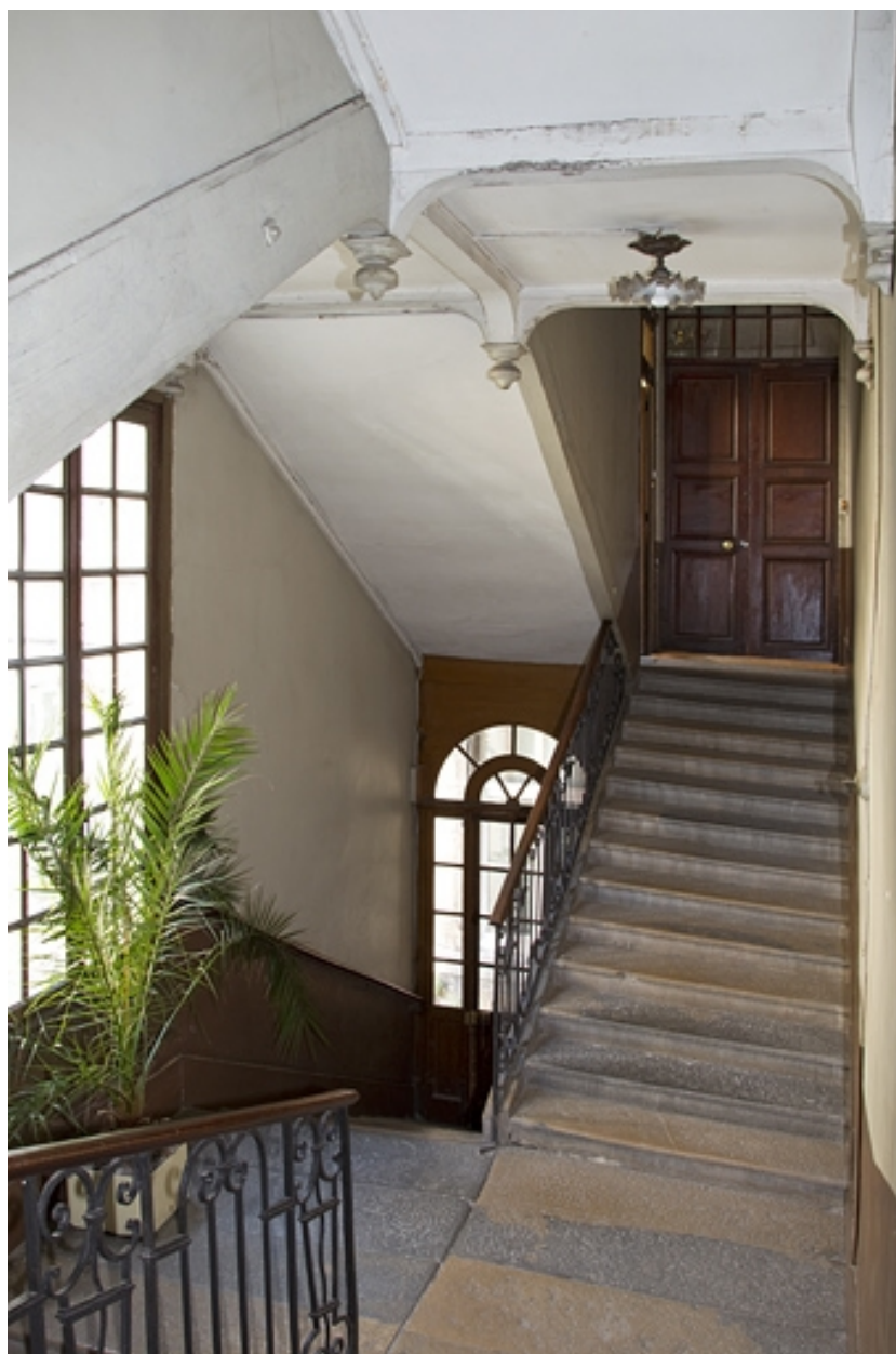
Vue d'ensemble de l'intérieur de l'escalier.
