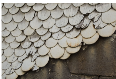
Détail des tavaillons recouvrant l'extérieur de la cage d'escalier : vue rapprochée. Phot. Yves Sancey IVR43_20112500877NUC2A
