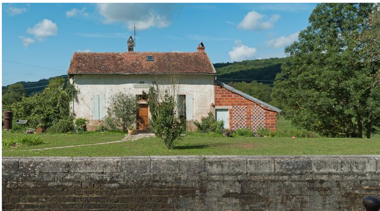
Vue de face de la maison éclusière.
