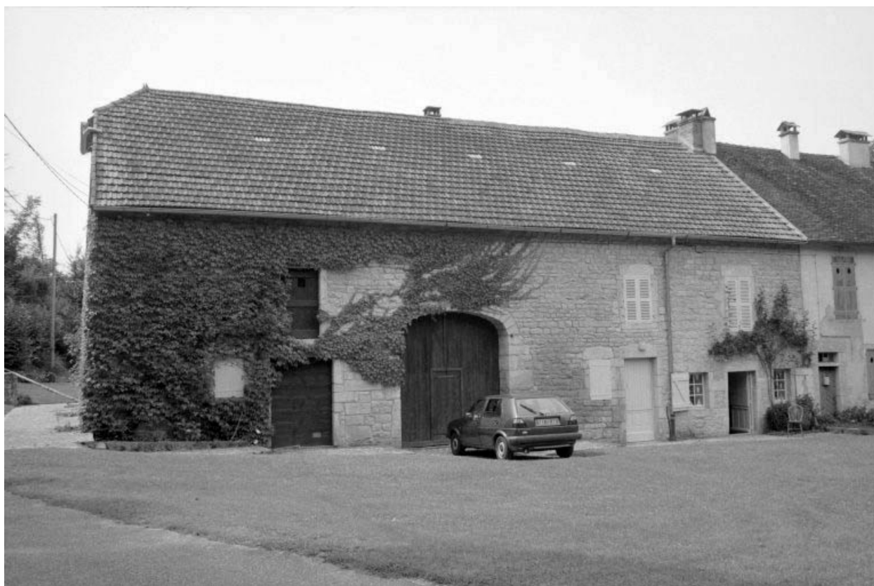
Façade postérieure de l'étable.
