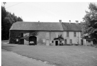
Façade postérieure du logement et de l'étable. Phot. Laurent Poupard IVR43_19933900539Z
