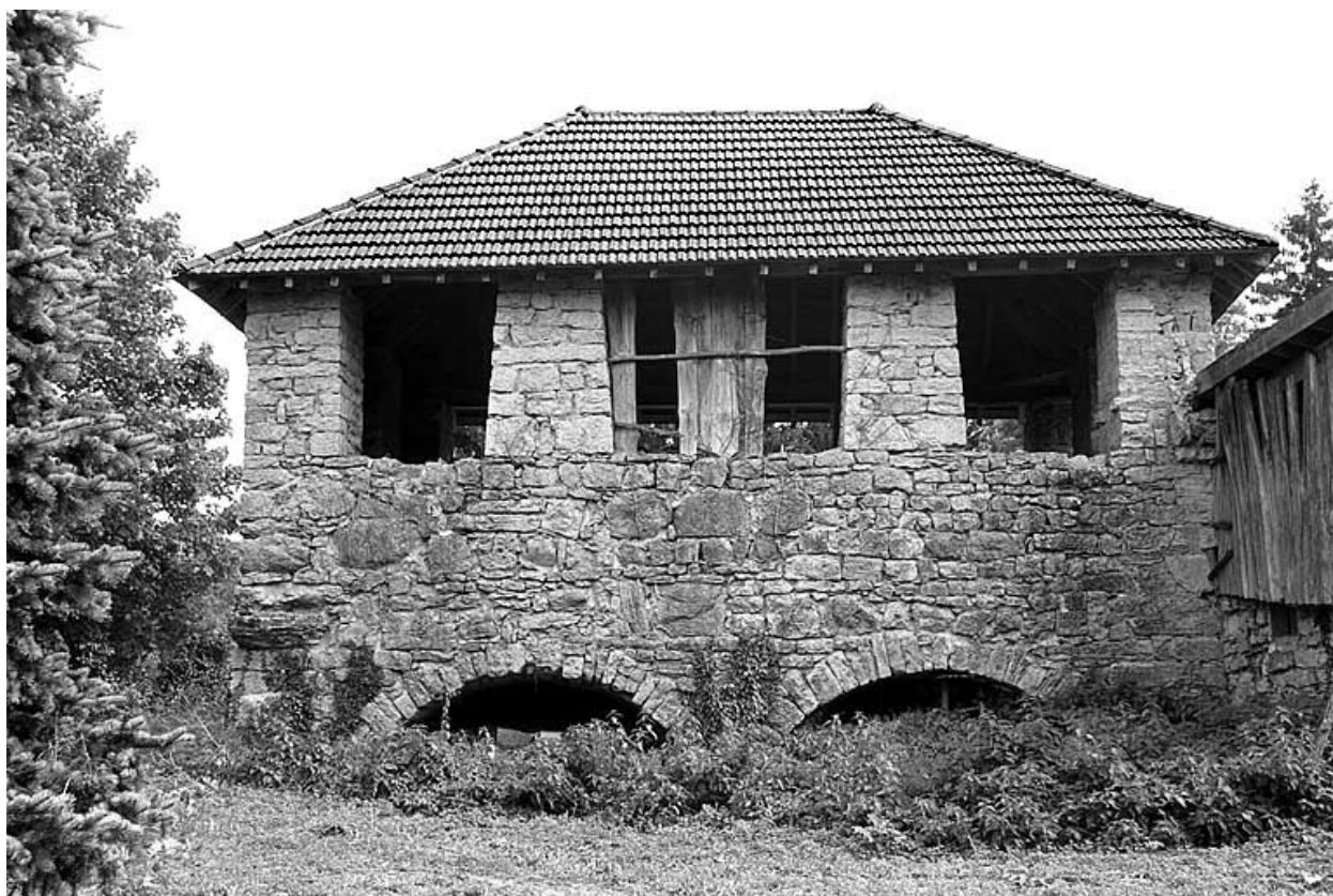
Four : ouvertures du foyer.
