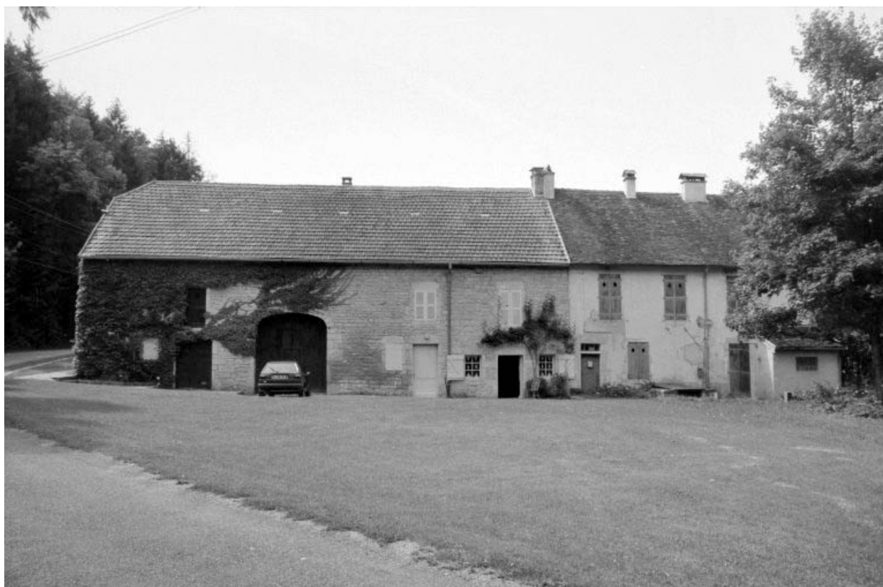
Façade postérieure du logement et de l'étable.
