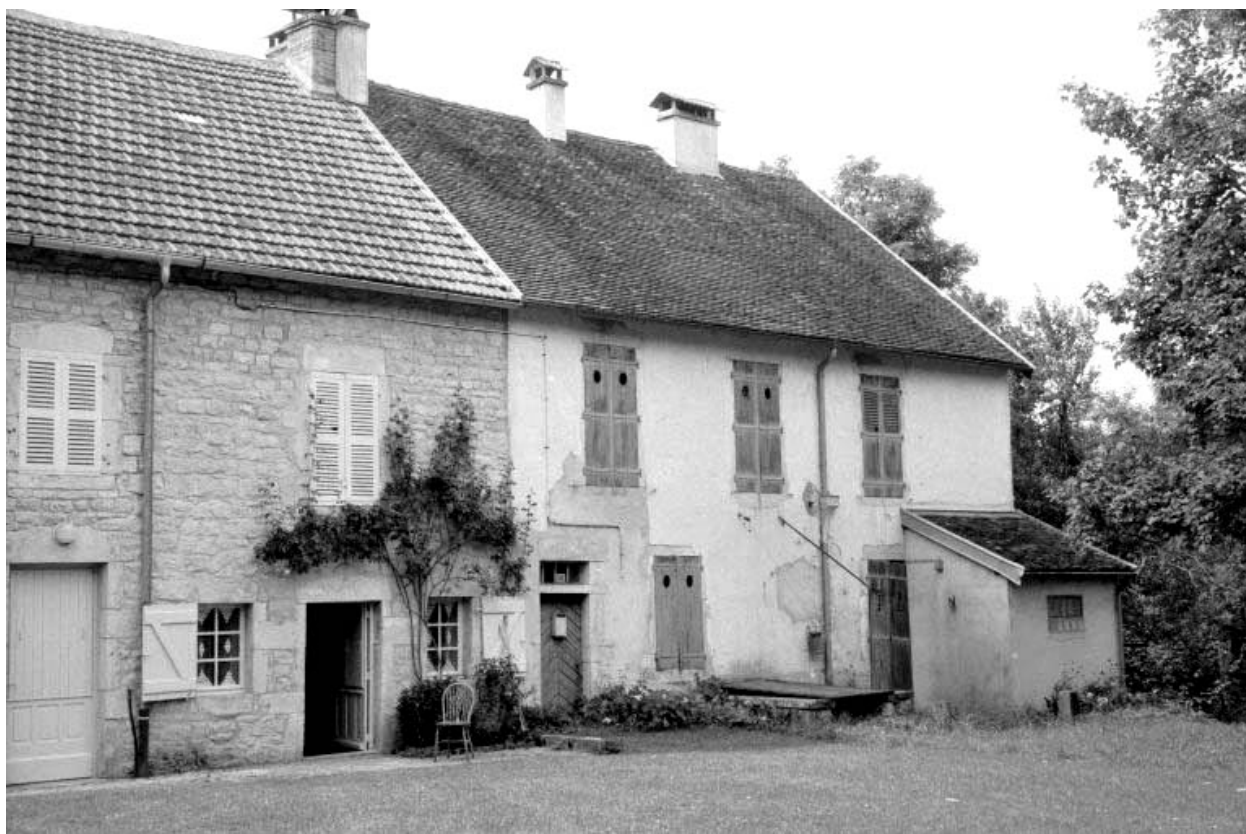
Façade postérieure du logement.
