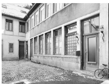
Atelier (à baies multiples). Phot. Yves Sancey IVR43_20033900721X
