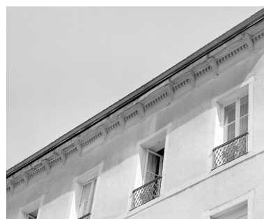
Façade antérieure : corniche. Phot. Yves Sancey IVR43_20033900718X
