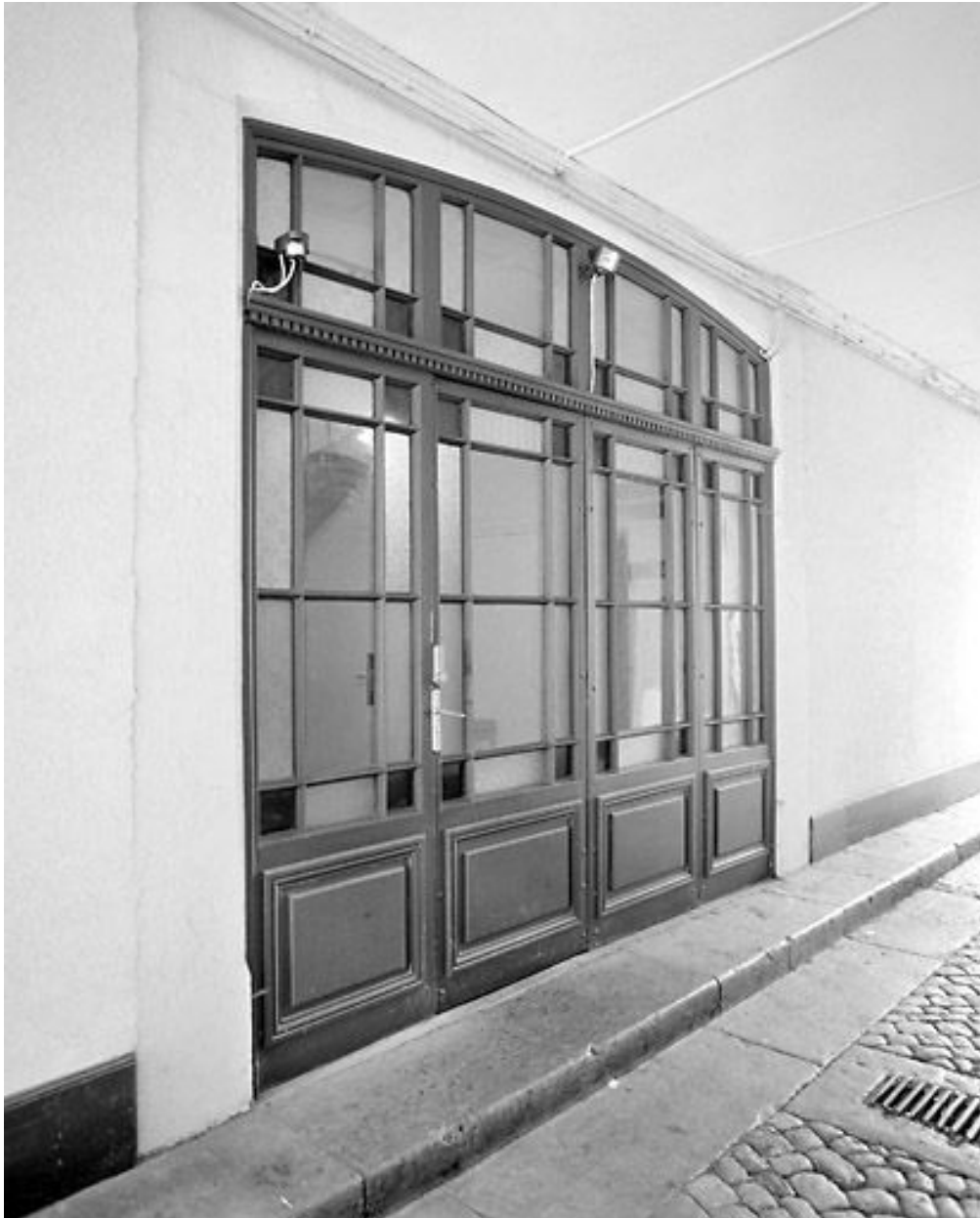
Passage couvert : porte de l'escalier.
