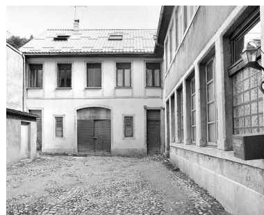
Cour et remise. Phot. Yves Sancey IVR43_20033900719X
