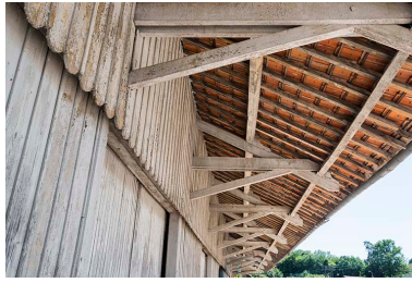
Détail de l'avant-toit de l'ancienne halle. Phot. Jérôme Mongreville IVR43_20177001008NUC4A
