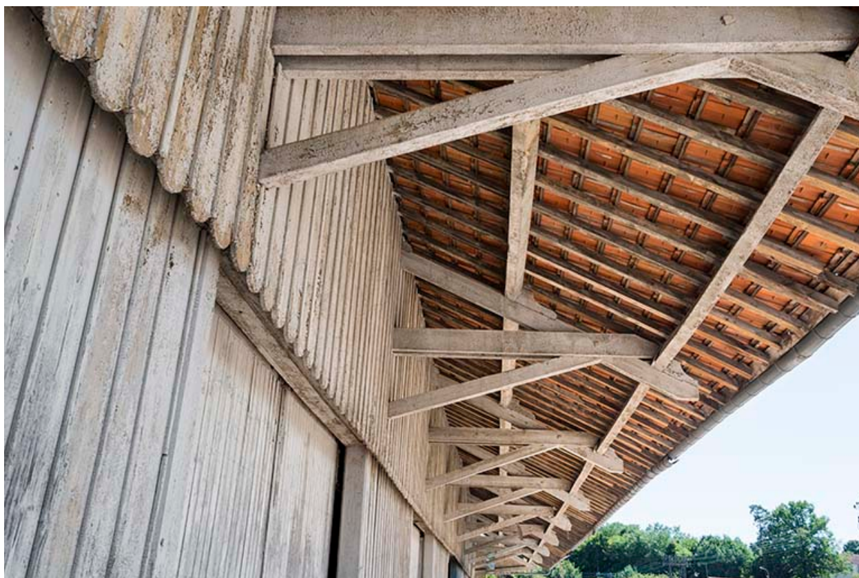
Détail de l'avant-toit de l'ancienne halle.
