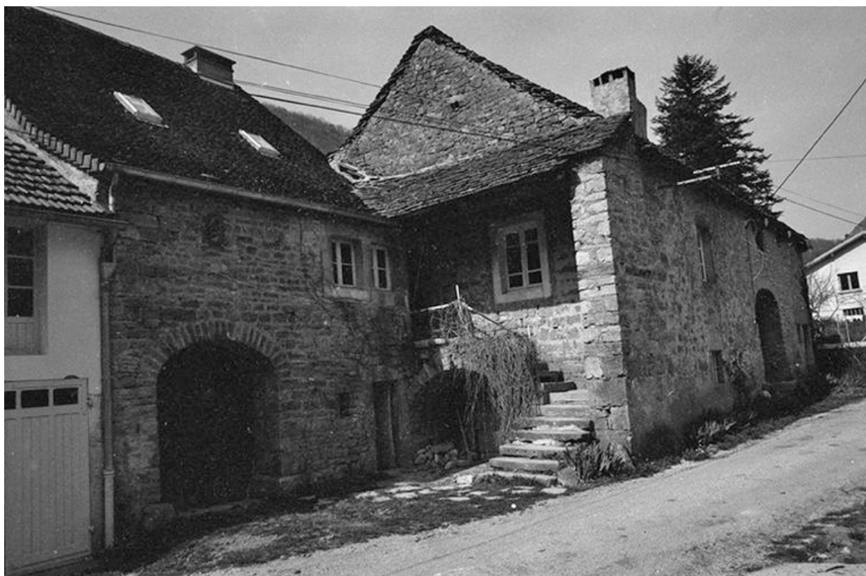
Ferme cadastrée 1964 AB : façade sur rue.
