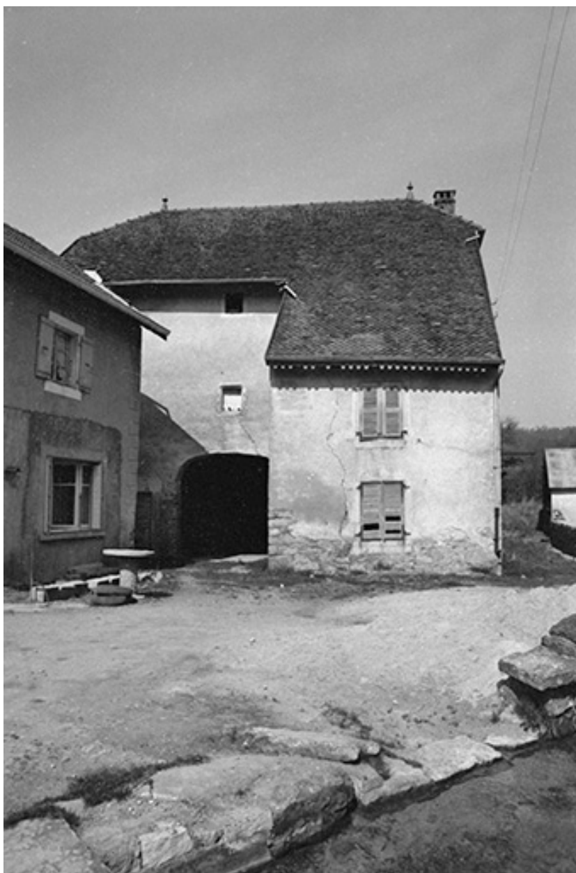
Maison cadastrée 1964 AB 106 : façade antérieure.
