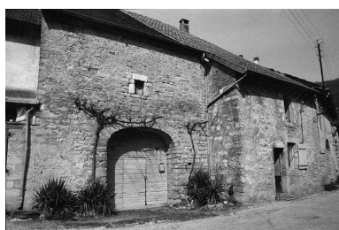
Ferme cadastrée 1964 AB 54 : façade antérieure. Phot. F. Pernin IVR43_19743900111Z
