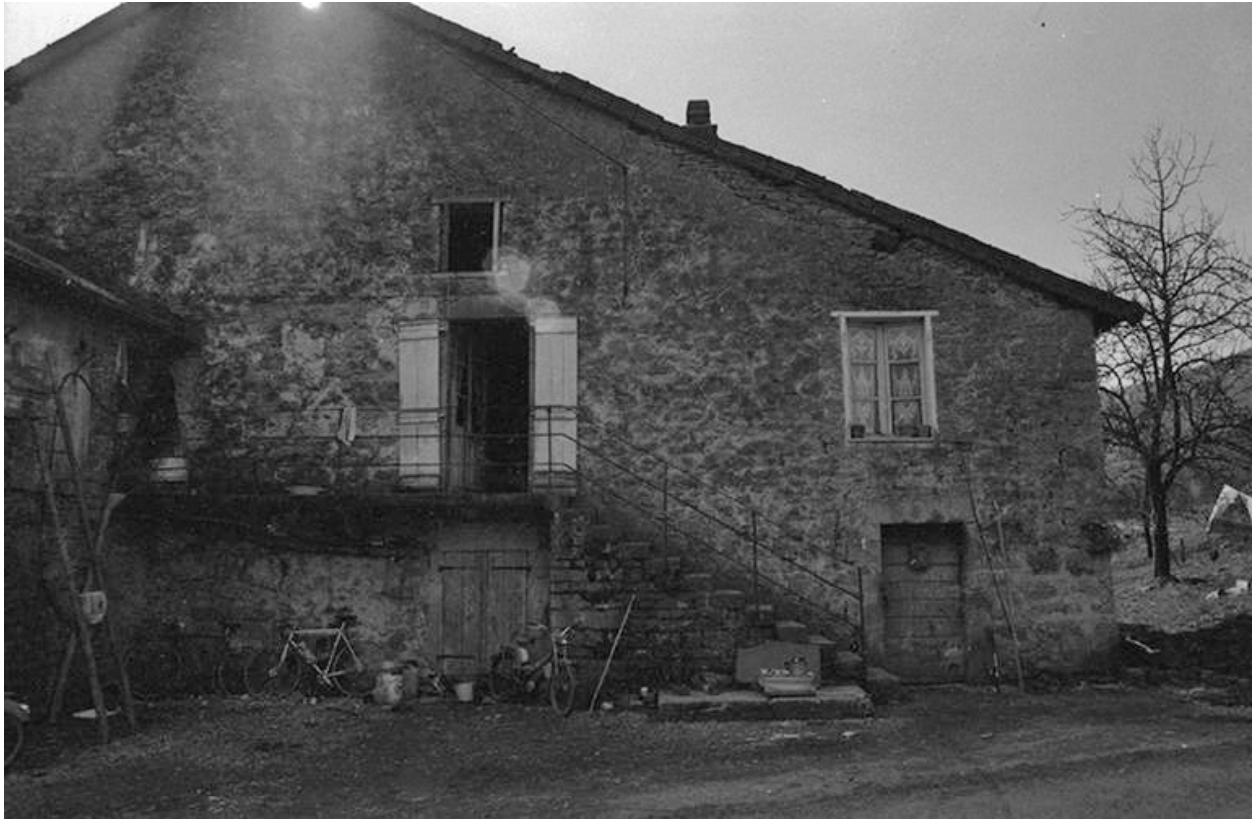
maison cadastrée 1964 AB 32 : façade antérieure.
