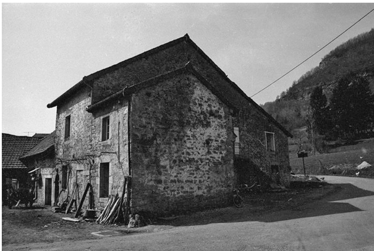
Maison cadastrée 1964 AB 32 : façade antérieure.
