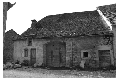
Ferme cadastrée 1964 AB 86 : façade est. Phot. F. Pernin IVR43_19743900117Z
