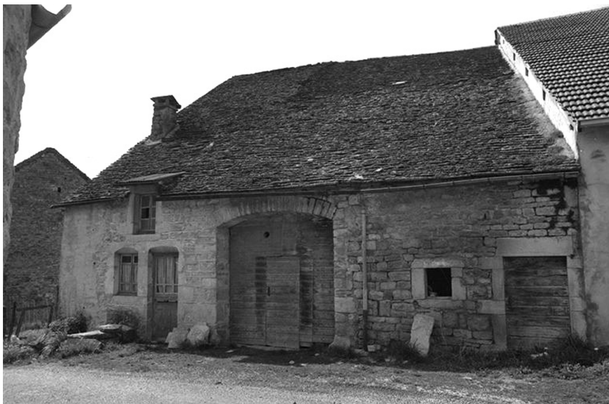
Ferme cadastrée 1964 AB 86 : façade est.
