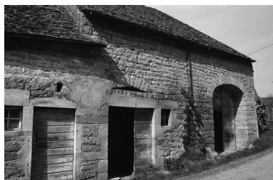
Ferme cadastrée 1964 AB 51 : façada antérieure vue de trois- quarts gauche, toit de laves. Phot. F. Pernin IVR43_19743900116Z
