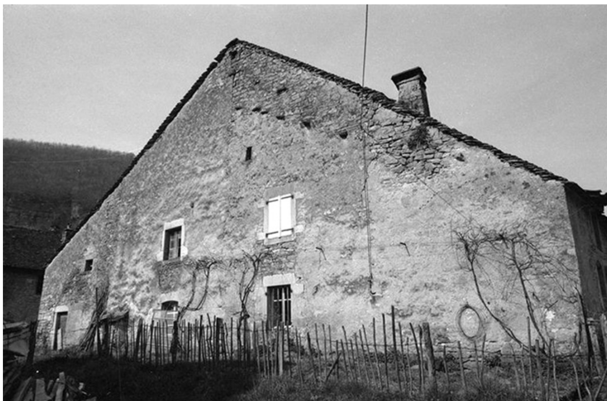
Ferme cadastrée 1964 AB 86 : façade sud.
