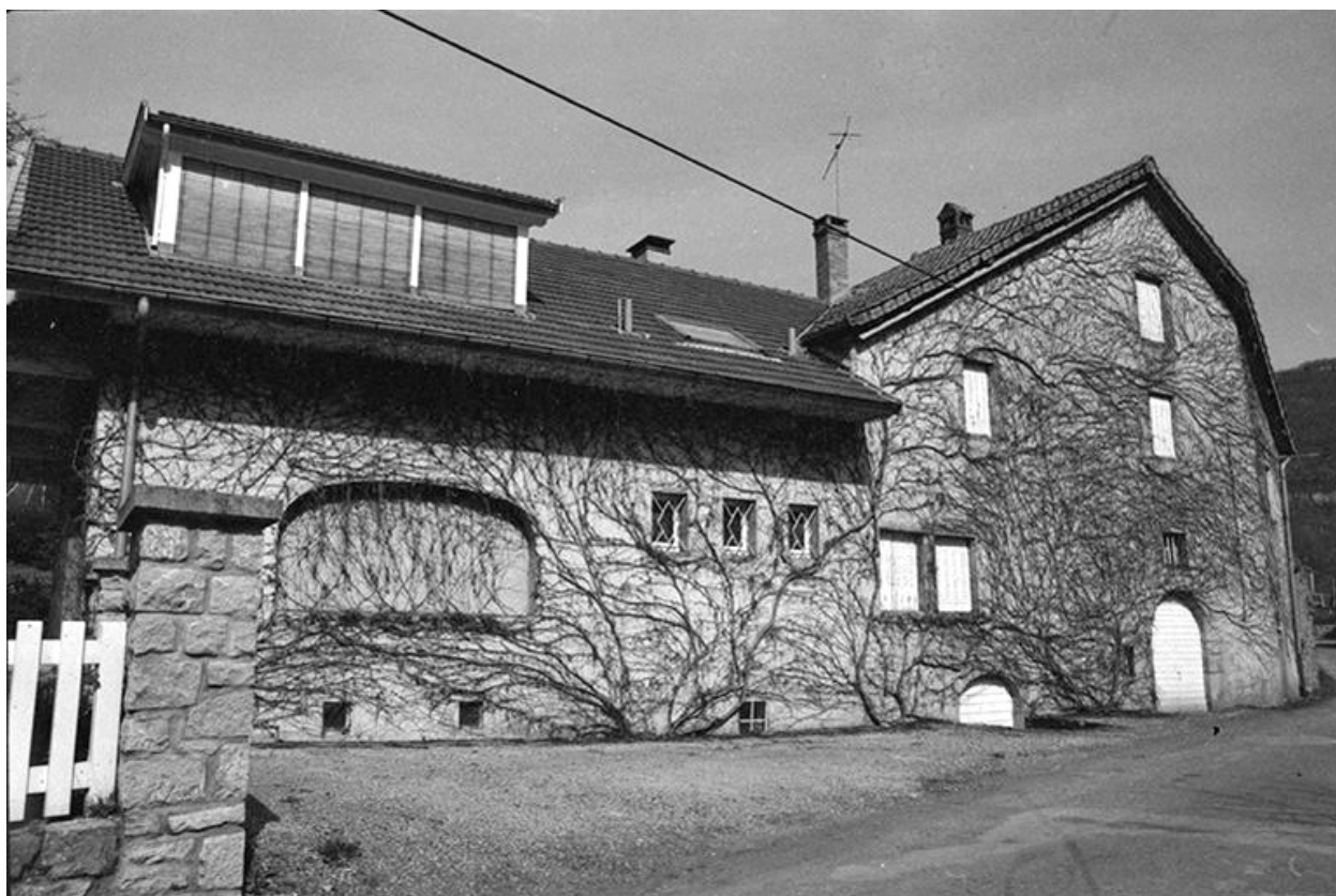
Maison cadastrée 1964 AB 13 : façade antérieure.
