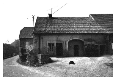
Ferme cadastrée 1964 AB 18 : façade antérieure. Phot. F. Pernin IVR43_19743900094Z
