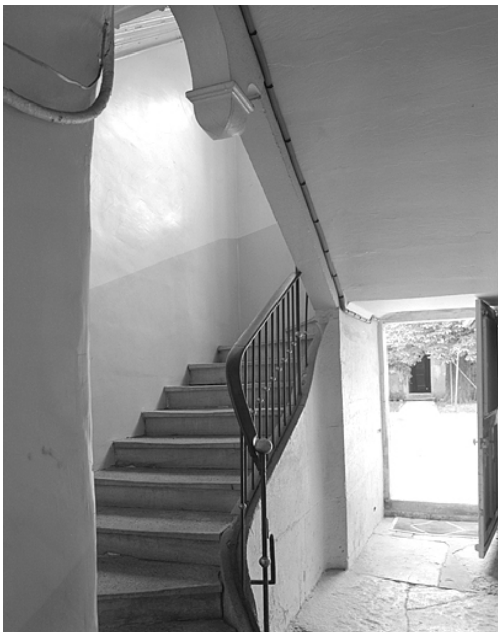
Escalier vu depuis le couloir.
