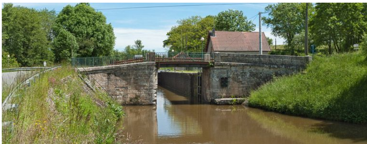
Le pont, vu d'aval.
