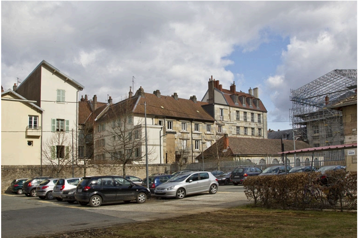
Vue d'ensemble éloignée de l'arrière de l'édifice.
