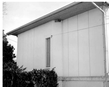
Façade latérale gauche : détail du mur. Phot. Yves Sancey IVR43_19943901615X
