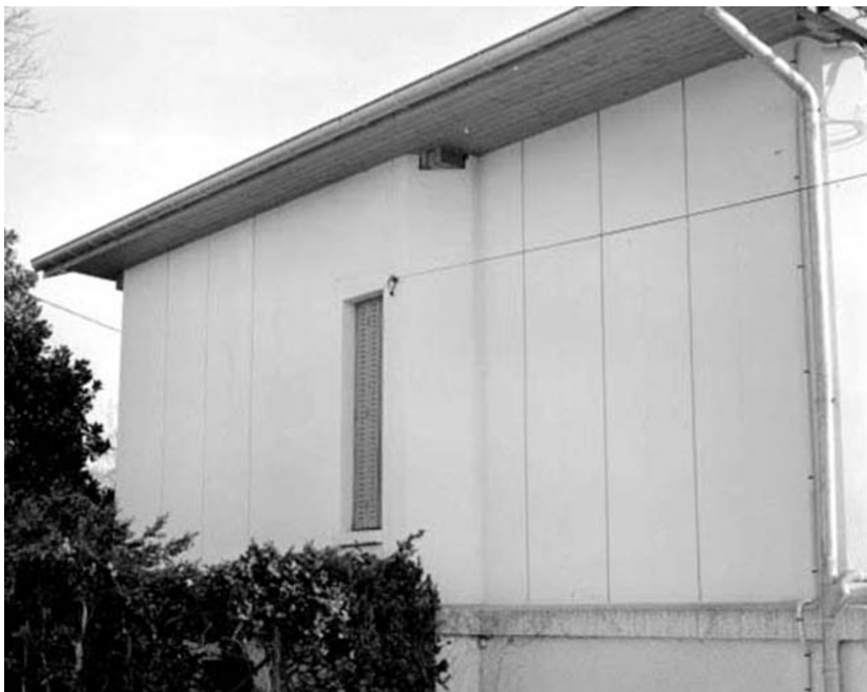
Façade latérale gauche : détail du mur.
