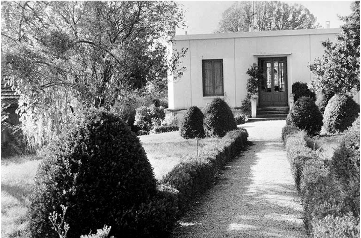
Façade postérieure avant restauration, novembre 1990.
