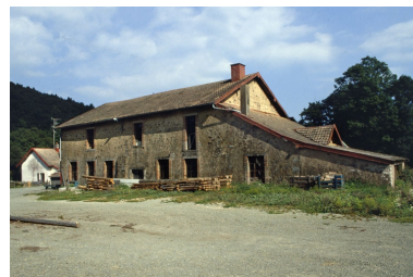
L'atelier de fabrication depuis le sud-est. Phot. Yves Sancey IVR43_19999000057ZA
