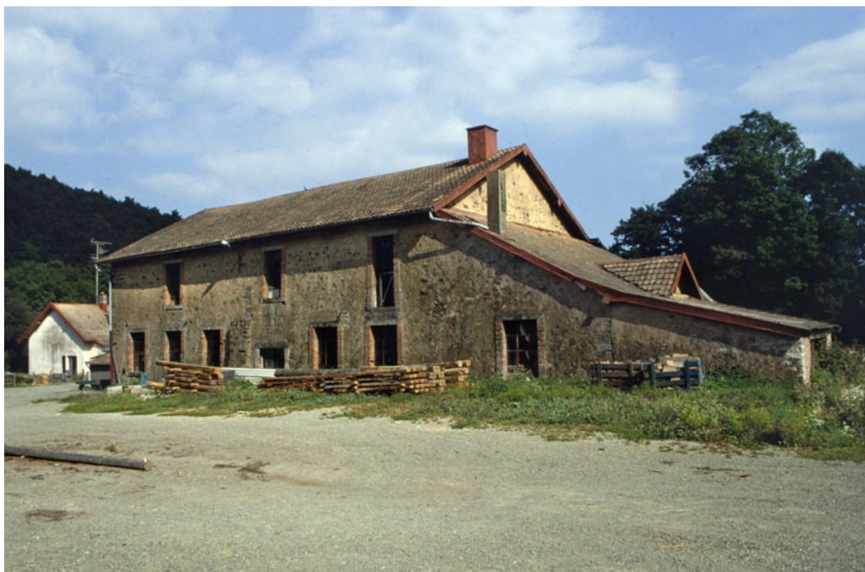
L'atelier de fabrication depuis le sud-est.
