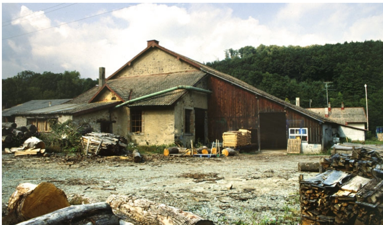
L'atelier de fabrication depuis le sud.
