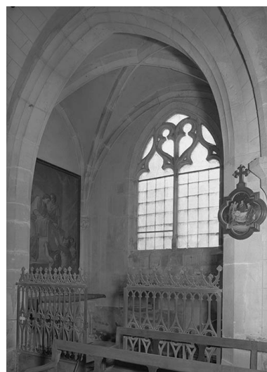
Chapelle latérale à croisée d'ogives. Phot. Jean-Luc Duthu IVR26_19748900860V
