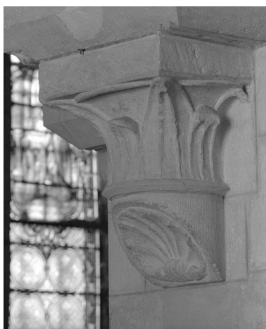
Nef, 2e travée, angle postérieur gauche. Chapiteau-console
