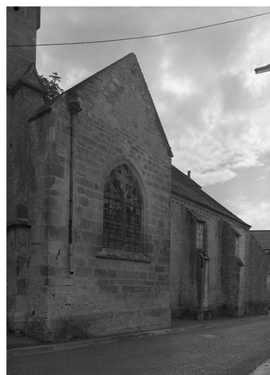
Façade du transept et bas-côté nord. Phot. Jean-Luc Duthu IVR26_19748900799V
