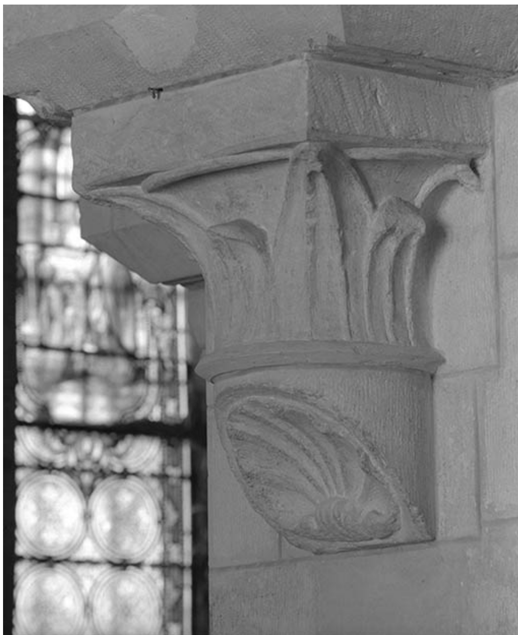
Nef, 2e travée, angle postérieur gauche. Chapiteau-console avec coquille Saint-Jacques sculptée au départ de la colonne.
