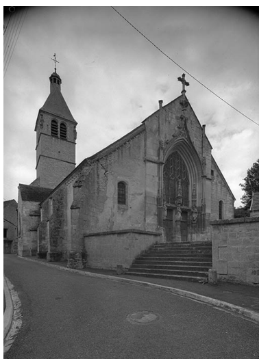
Façade occidentale avec portail et clocher (en arrière-plan). Phot. Jean-Luc Duthu IVR26_19748900800V
