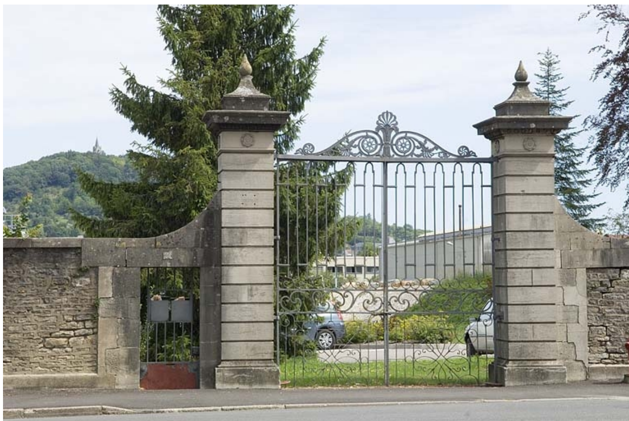
Grille d'entrée de l'ancien logement patronal.
