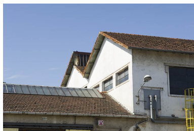
Toiture d'un magasin industriel. Phot. Jérôme Mongreville IVR43_20097000831NUC2A
