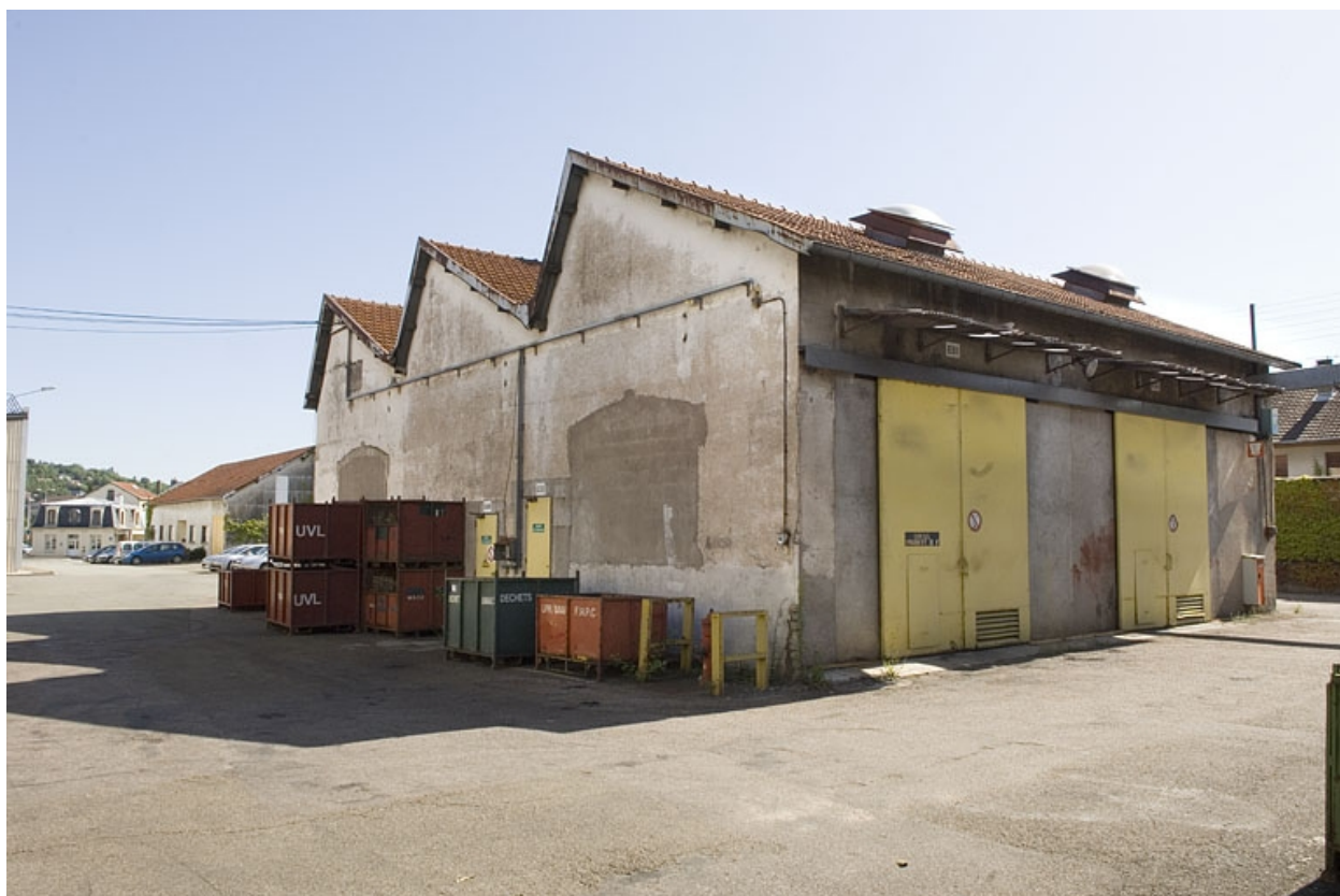
Salle des machines et chaufferie (usine Dollé).
