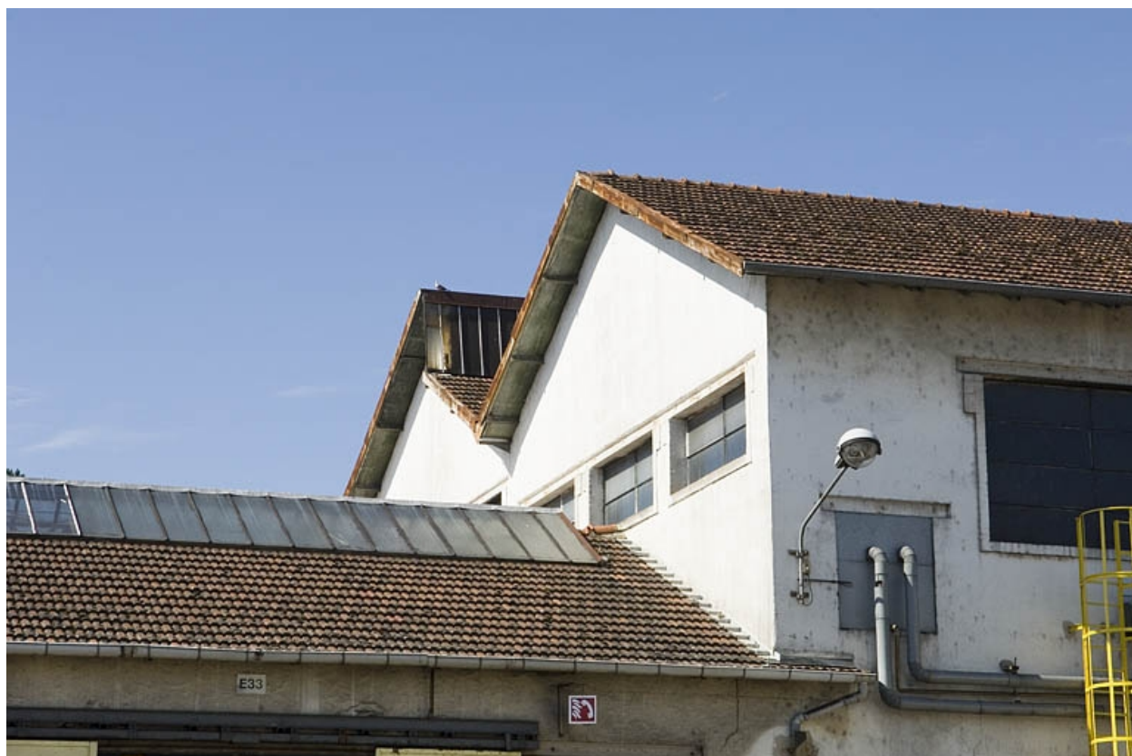
Toiture d'un magasin industriel.
