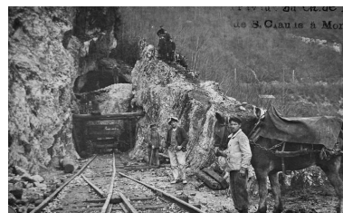
Travaux du Ch. de Fer de S. Claude à Morez [perçement du tunnel du Pain de Sucre, avec personnages et chantier côté La Cluse], 1909-1910. Phot. IVR43_20073900180NUCA
