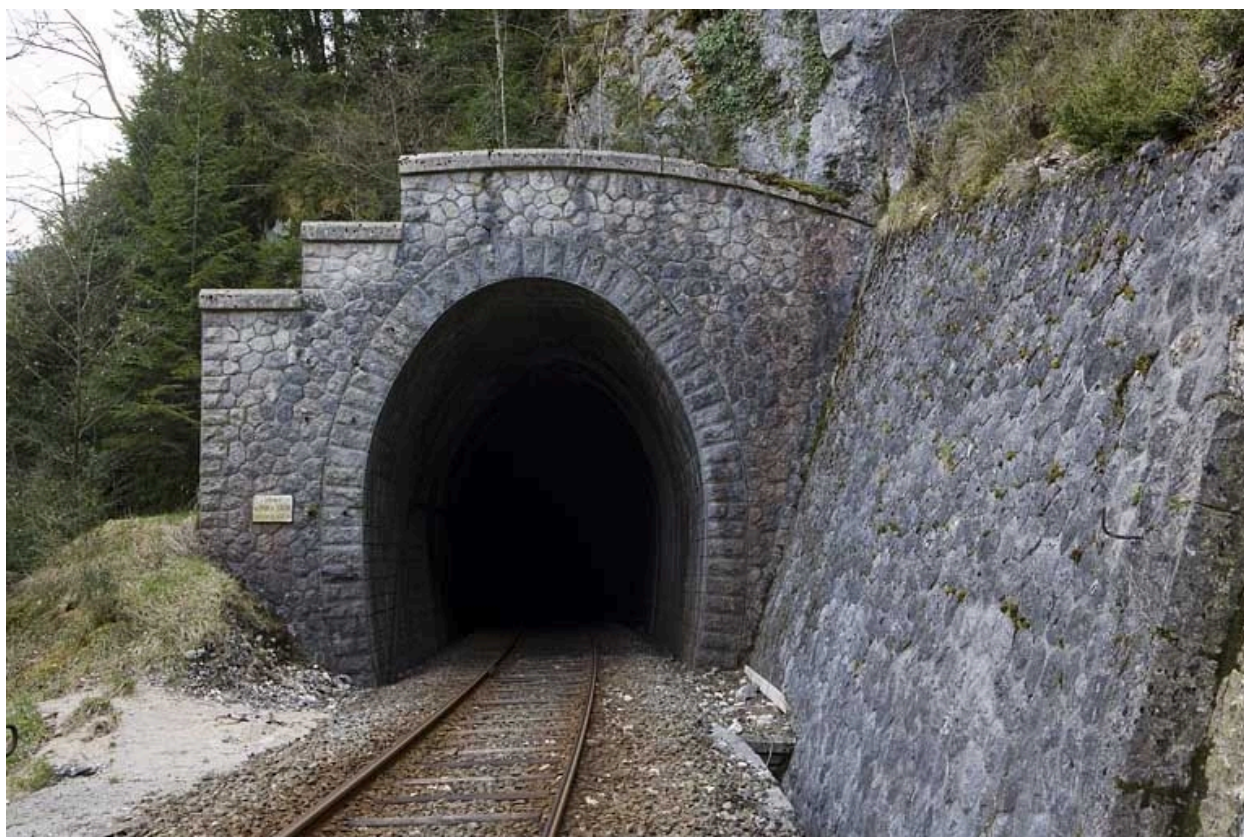
Tunnel : tête côté Andelot-en-Montagne (nord).
