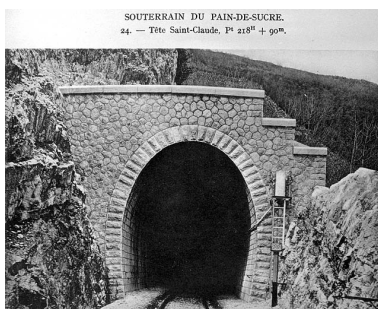
Souterrain du Pain-de-Sucre.
