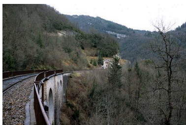
Extrémité du viaduc côté Andelot-en-Montagne, depuis le sud.
