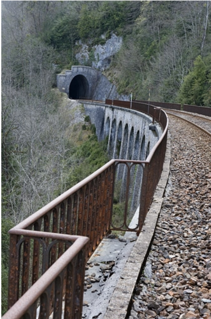
Vue d'ensemble, depuis l'extrémité du viaduc côté Andelot-en-Montagne (nord).
