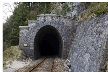
Tunnel : tête côté Andelot-en-Montagne (nord).
