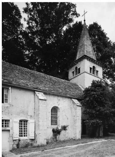
Vue de l'élévation gauche. Phot. Jean-Luc Duthu IVR26_19792101111V
