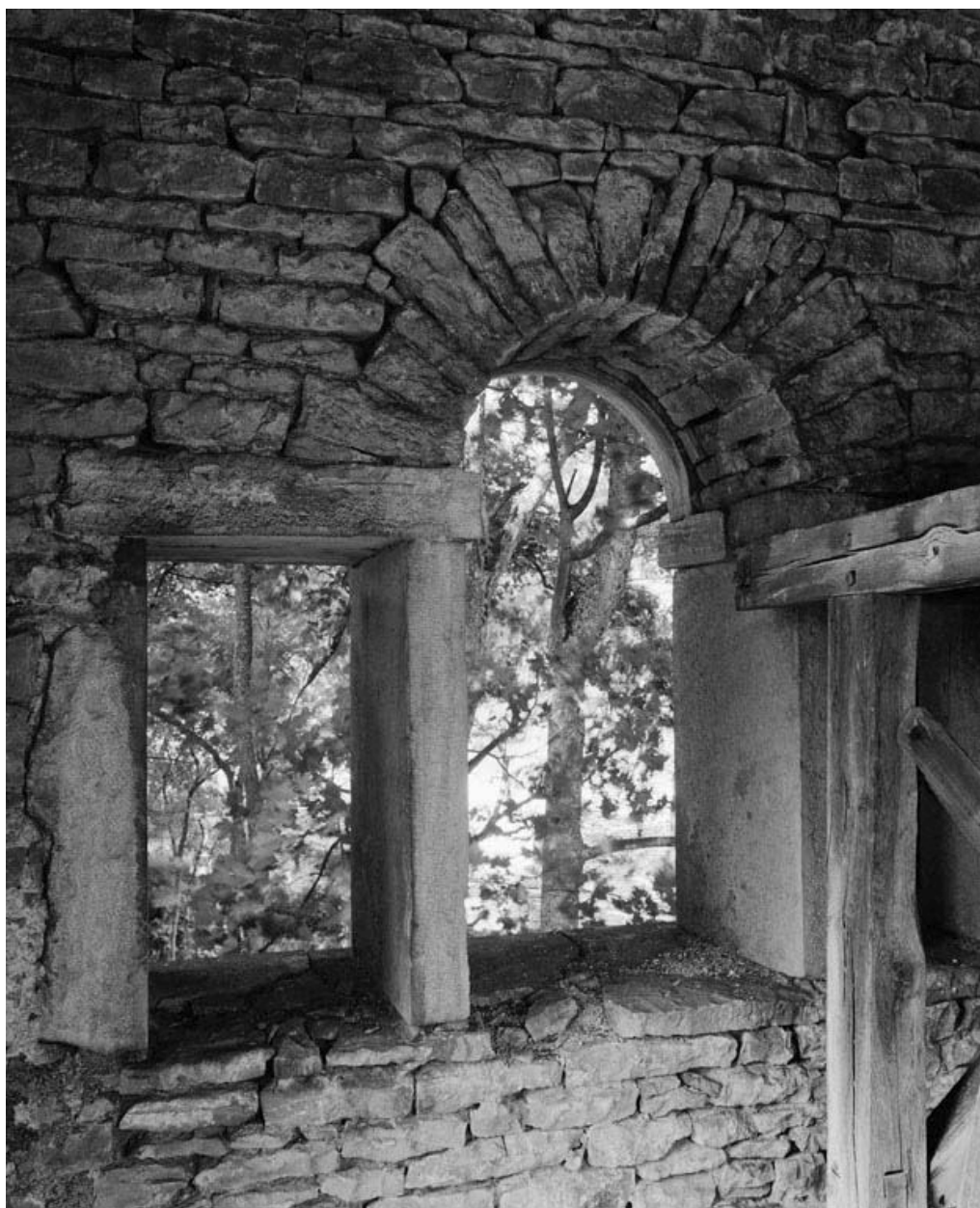
Vue intérieure des baies antérieures du clocher.
