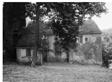
Vue de l'élévation droite. Phot. Jean-Luc Duthu IVR26_19792101109V
