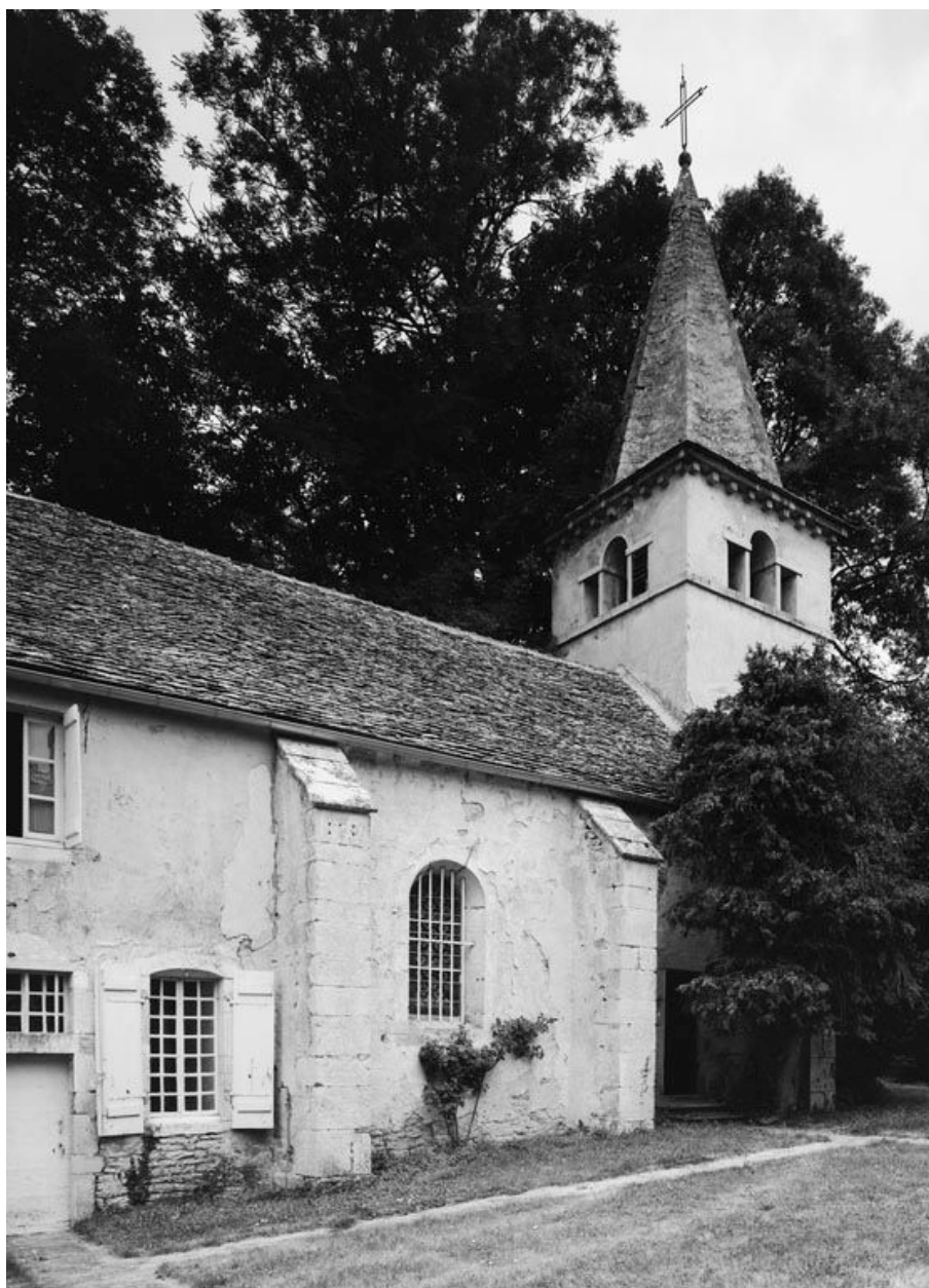
Vue de l'élévation gauche.
