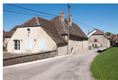
Rue Ménans Phot. Jérôme Mongreville IVR43_20137000166NUCA
