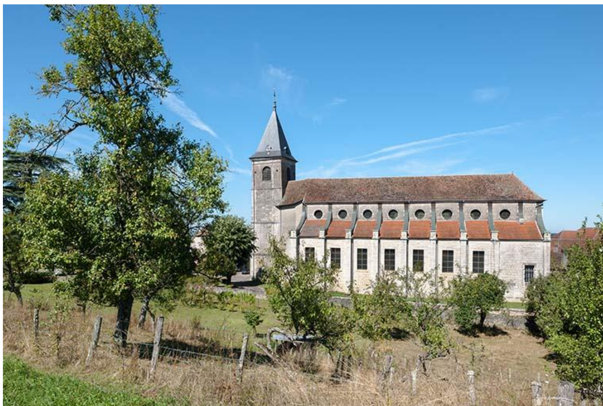
Vue générale sud de l'église
