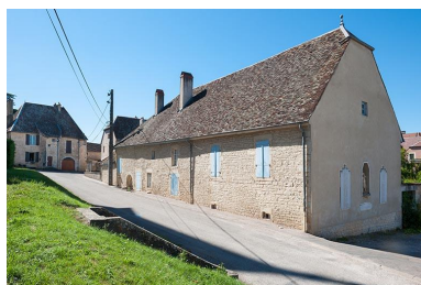
Ancienne ferme située rue Ménans Phot. Jérôme Mongreville IVR43_20137000168NUCA
