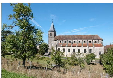
Vue générale sud de l'église Phot. Jérôme Mongreville IVR43_20137000227NUCA
