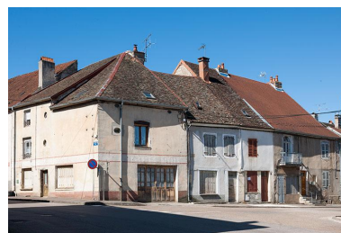
Maisons de la rue de la Champlitte Phot. Jérôme Mongreville IVR43_20137000200NUCA
