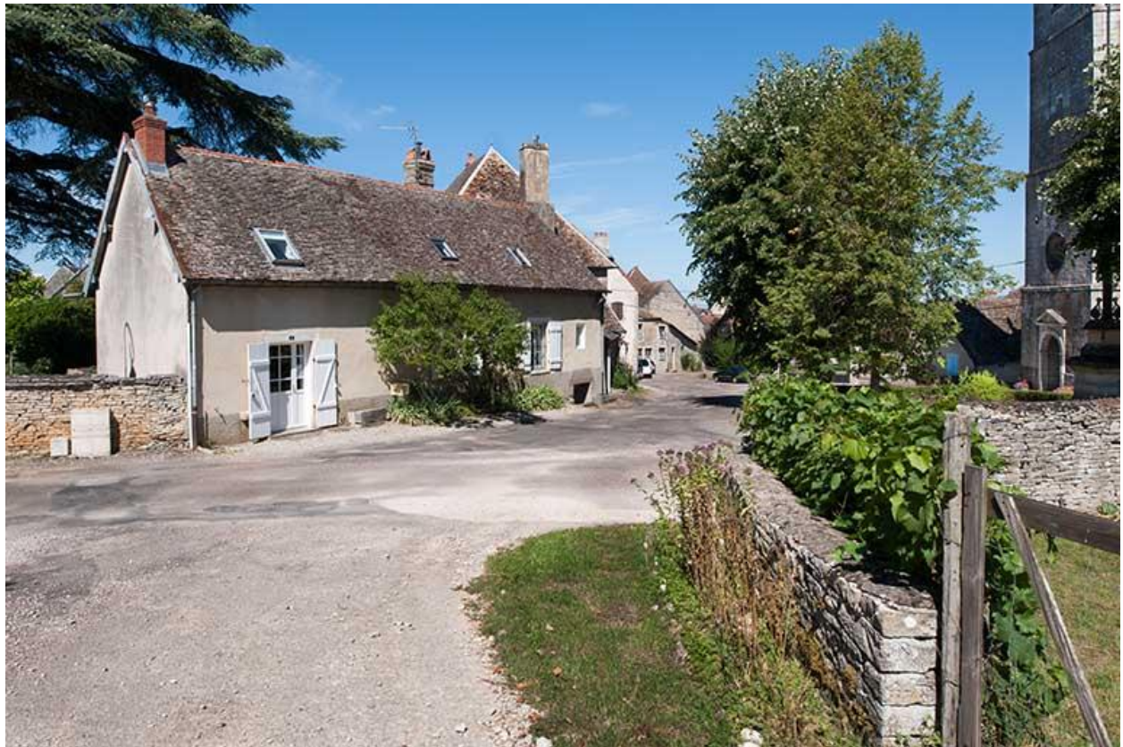
Bâtiment situé place de l'Eglise
