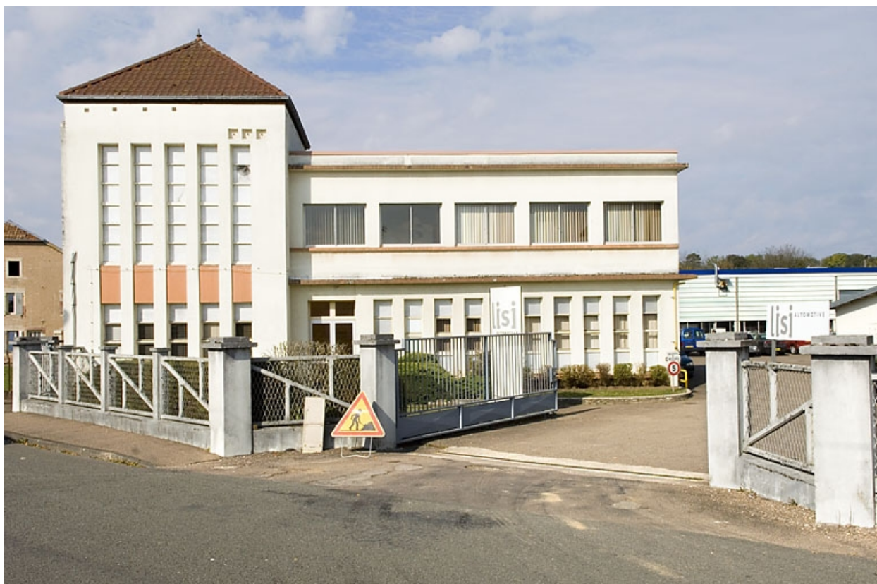
Façade antérieure. Transformateur et bureau.
