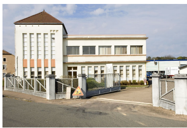
Façade antérieure. Transformateur et bureau. Phot. Jérôme Mongreville IVR43_20077000668NUCA
