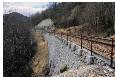
Vue d'ensemble, depuis le côté Andelot-en-Montagne (nord). Premier mur (avec aqueduc) au premier plan, deuxième mur à l'arrière-plan. Phot. Yves Sancey IVR43_20053900689ZA
