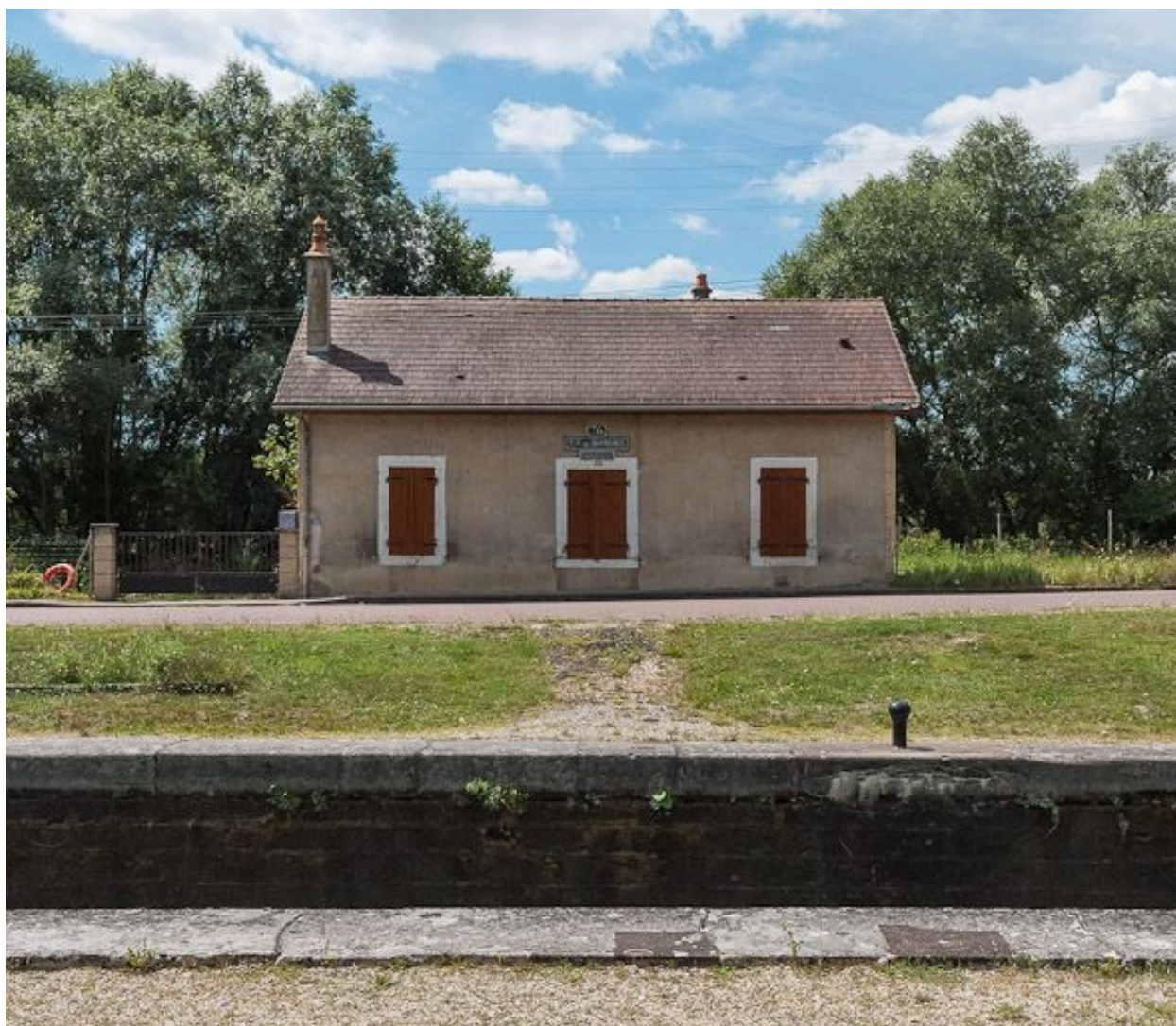
La maison éclusière de face.
