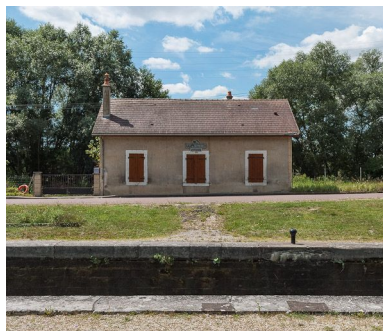
La maison éclusière de face.
