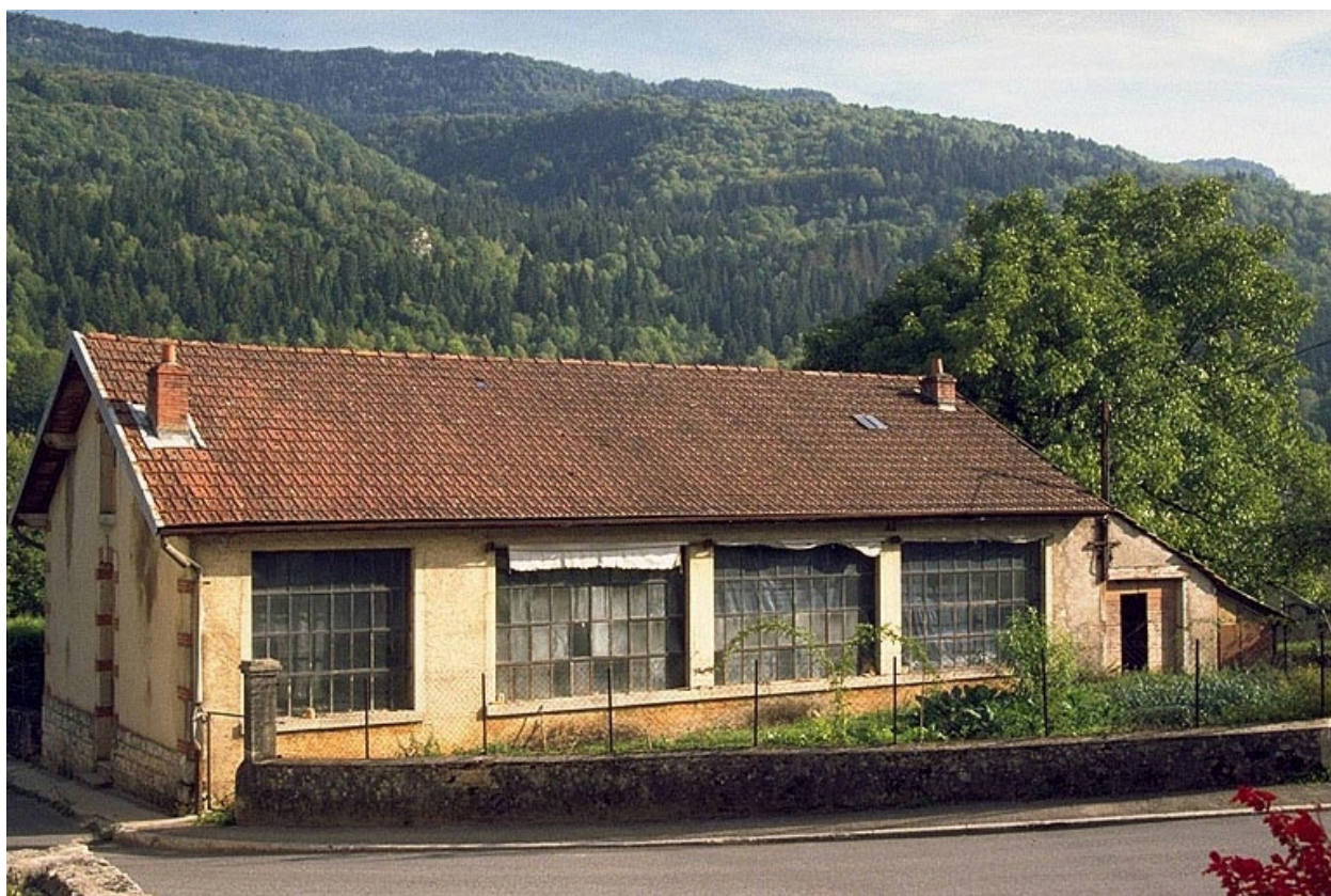
Façade latérale droite de l'atelier de fabrication.
