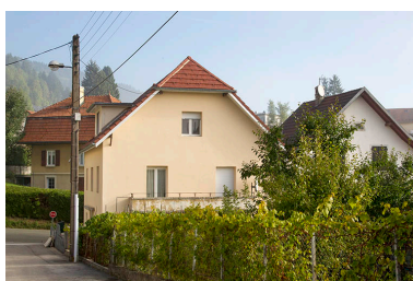
Façade latérale droite. Phot. Yves Sancey IVR43_20132502341NUC2A
