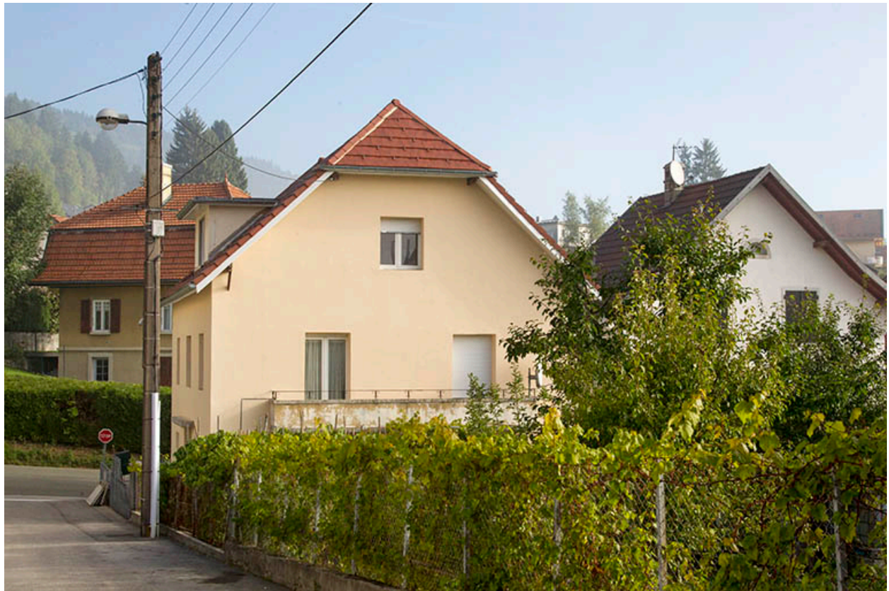
Façade latérale droite.
