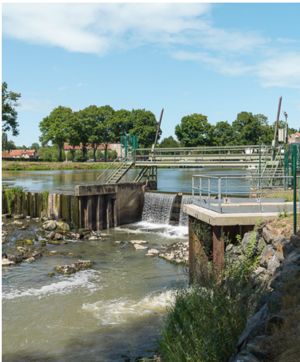
Vue du barrage.
