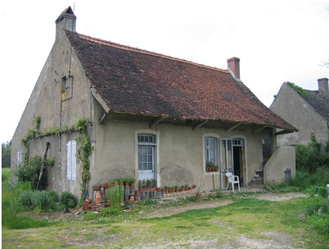
Vue d'ensemble de la façade.
