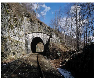
Vue d'ensemble, côté La Cluse (sud). Phot. Yves Sancey IVR43_20053900577XA
