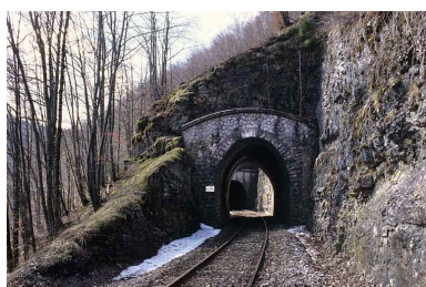
Vue d'ensemble, côté Andelot- en-Montagne (nord). Tunnel du Grépillon à l'arrière-plan. Phot. Yves Sancey IVR43_20053900579ZA
