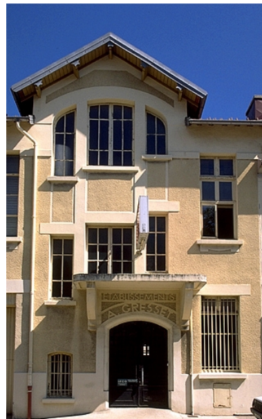
Détail de la façade antérieure.
